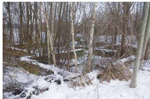
Būves pamati ar kadastra apzīmējumu 6409 002 0141 001
