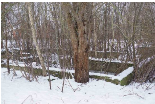
Būves pamati ar kadastra apzīmējumu 6409 002 0141 001
