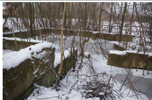
Būves pamati ar kadastra apzīmējumu 6409 002 0141 001
