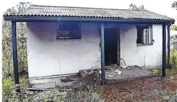
1.attēls. Galvenā fasāde
