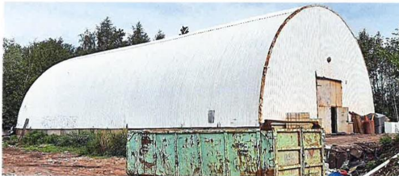
1.attēls. Galvenā fasāde
