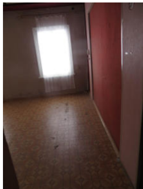
11.attēls. Zāle (1.stāva telpa Nr.1)
