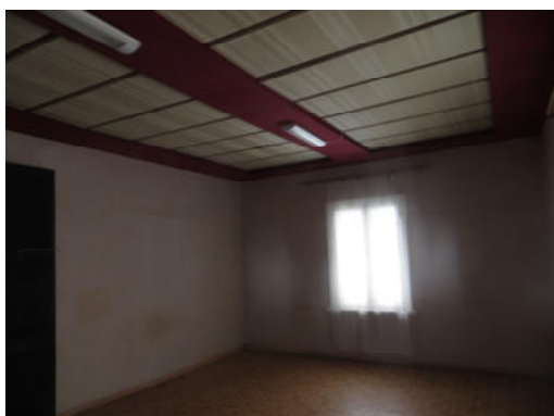
13.attēls. Zāle (1.stāva telpa Nr.1)
