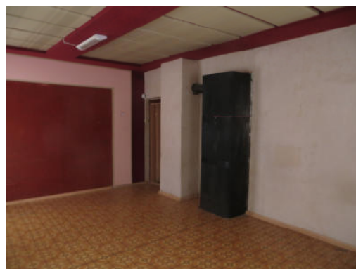
14.attēls. Zāle (1.stāva telpa Nr.1)
