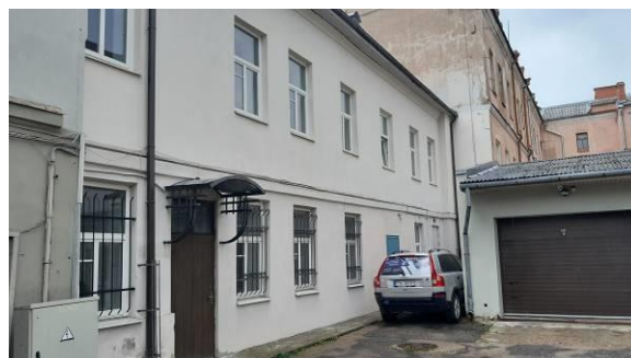
Administratīvās ēkas pagalma fasāde
