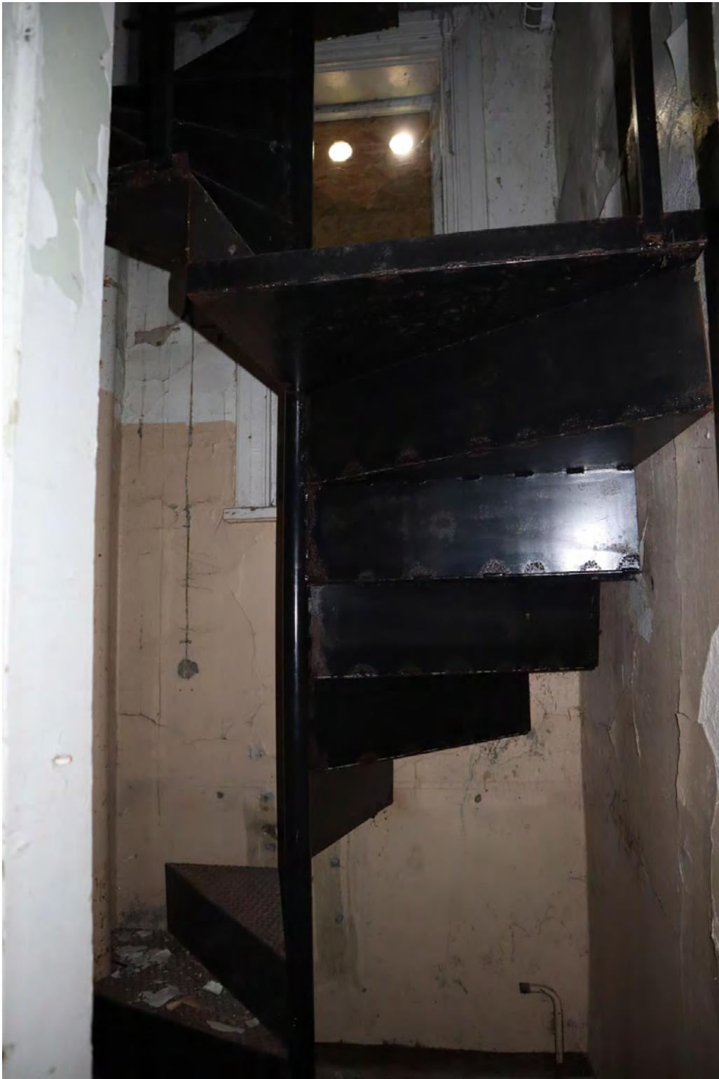
30.att. Metāla vītņu kāpnes ēkas Z daļā.
