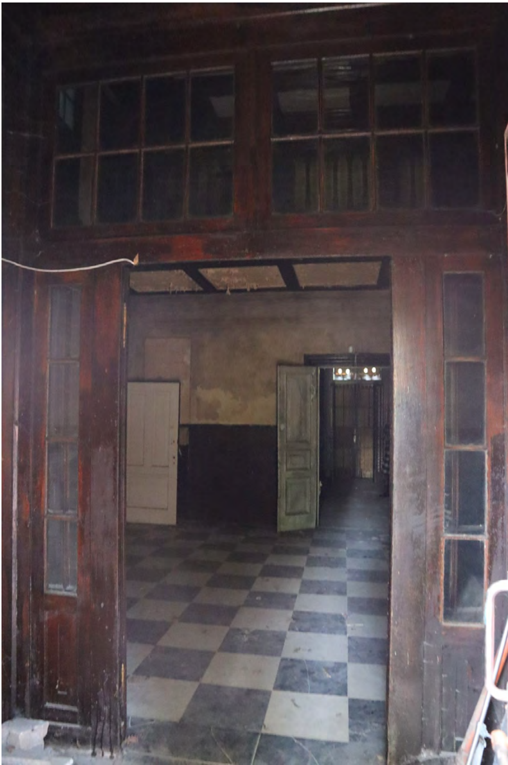
32.att. 1. stāva vestibils ar vējtveri.
