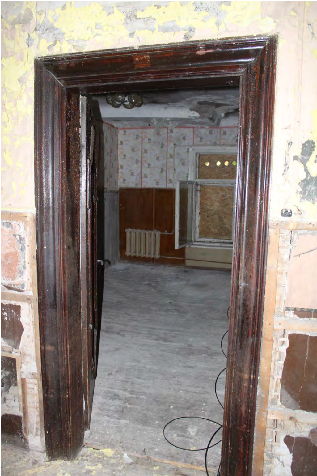
58.att. Koka aploda ar noseglīstēm un vēsturiskajām durvīm 2. stāvā.
