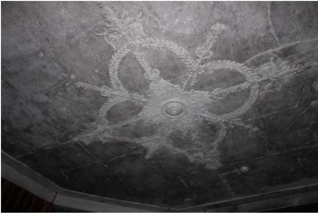
39.att. 1. stāva iekštelpu griestu plafons.
