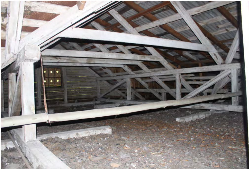
59.att. Bēniņu fragments ar jumta konstrukcijām.
