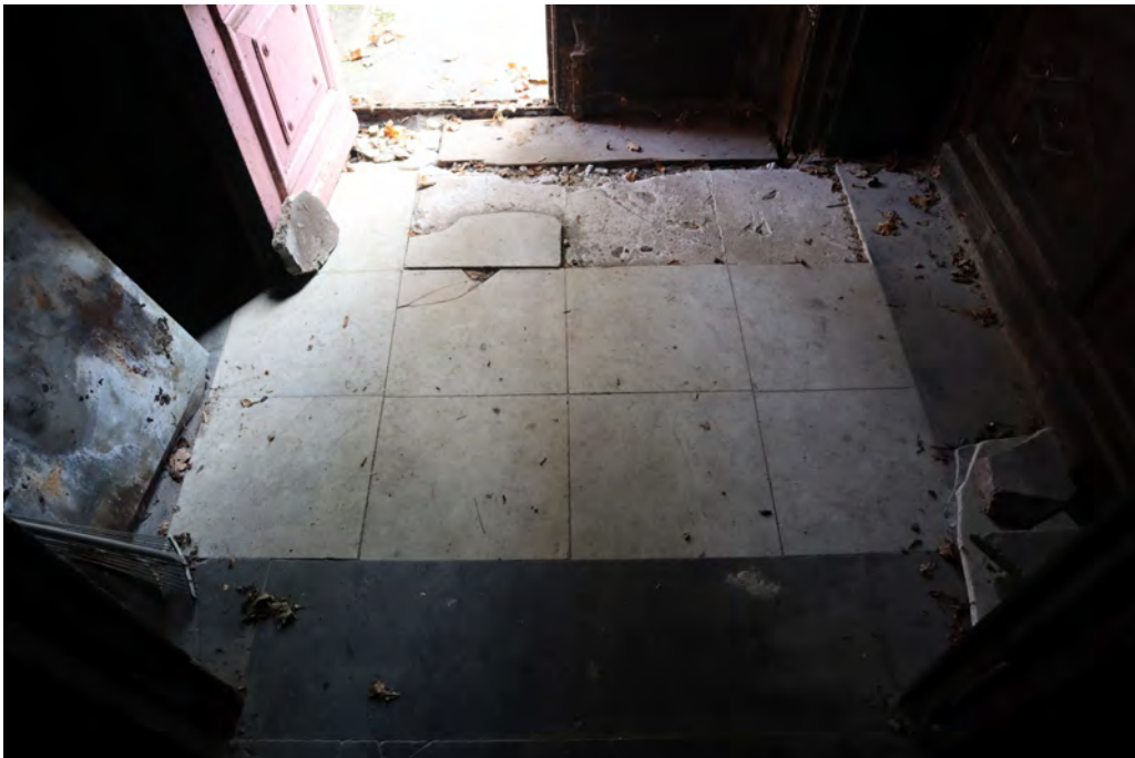
10.att. Vējtverī zudusās un bojātās marmora flīzes.
