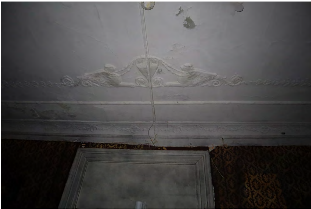
20.att. 1. stāva iekštelpu griestu plafons.
