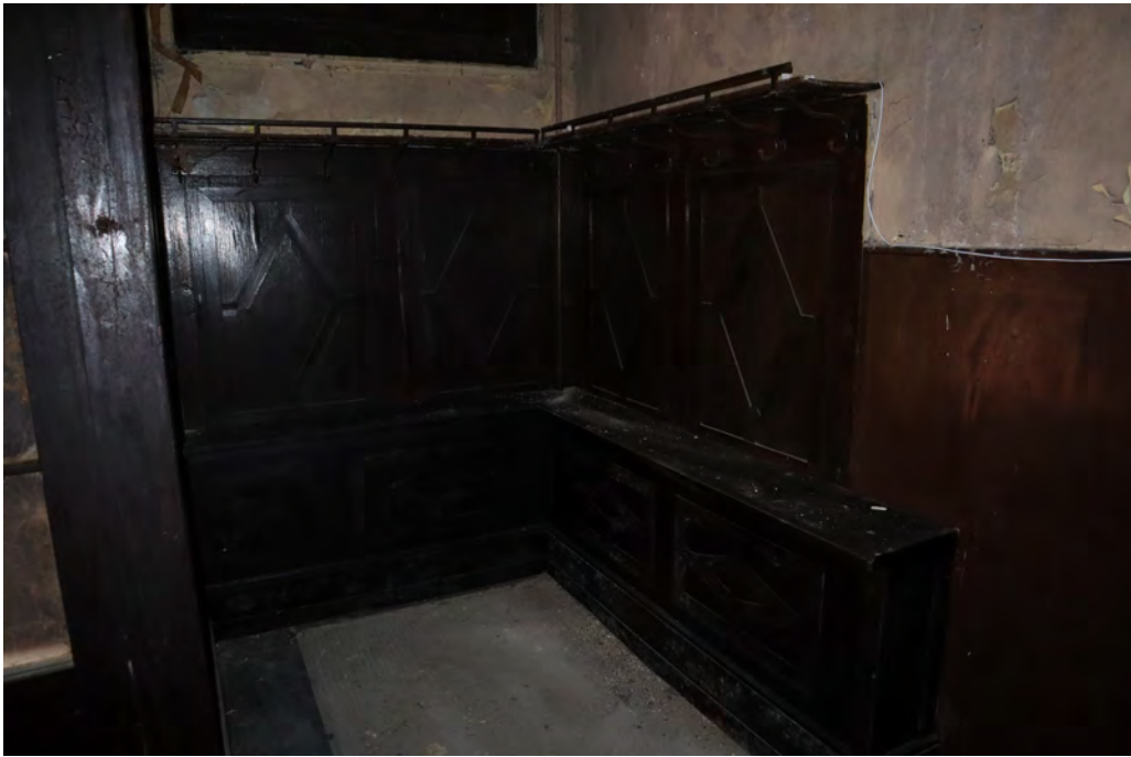
81.att. Koka paneli 1. stāva vestibilā.
