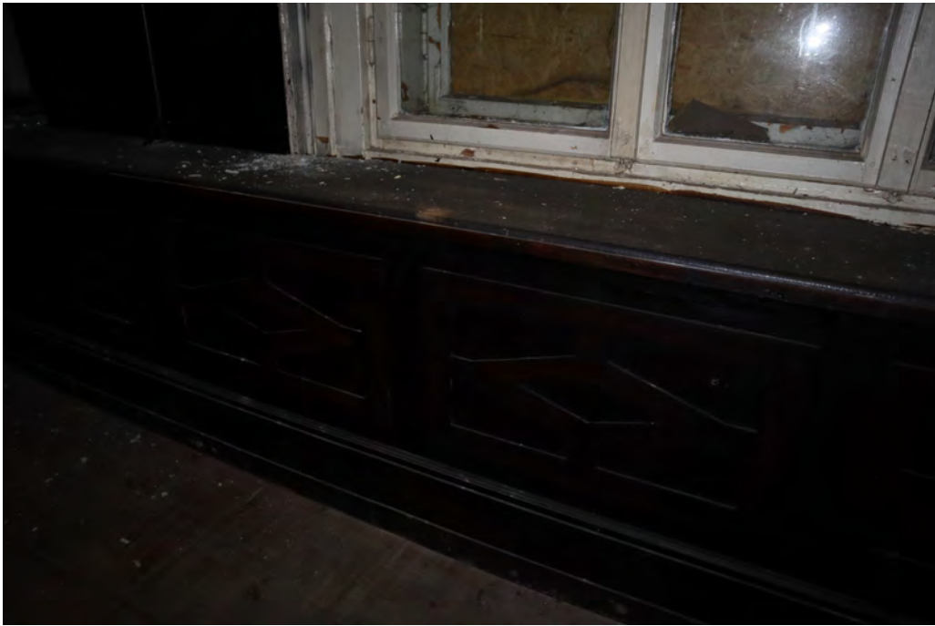
26.att. Koka panelējums zem logiem 1. stāva telpās.
