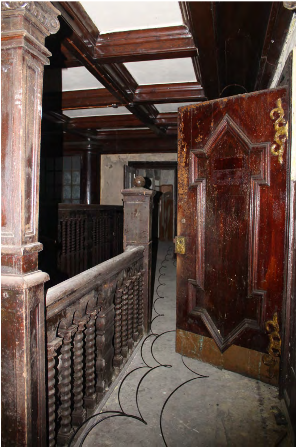
66.att. 2. stāva iekštelpu fragments.
