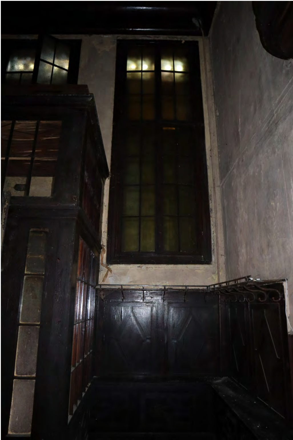
4.att. Logi A fasādē 1. stāva vestibilā.
