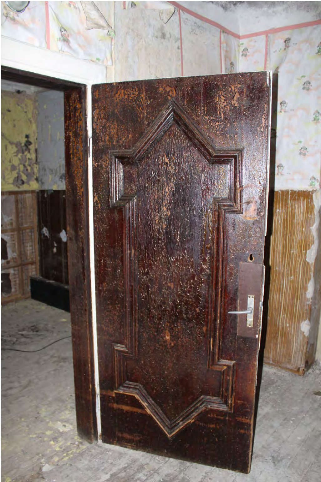
61.att. Koka aploda ar noseglīstēm un vēsturiskajām durvīm 2. stāvā.
