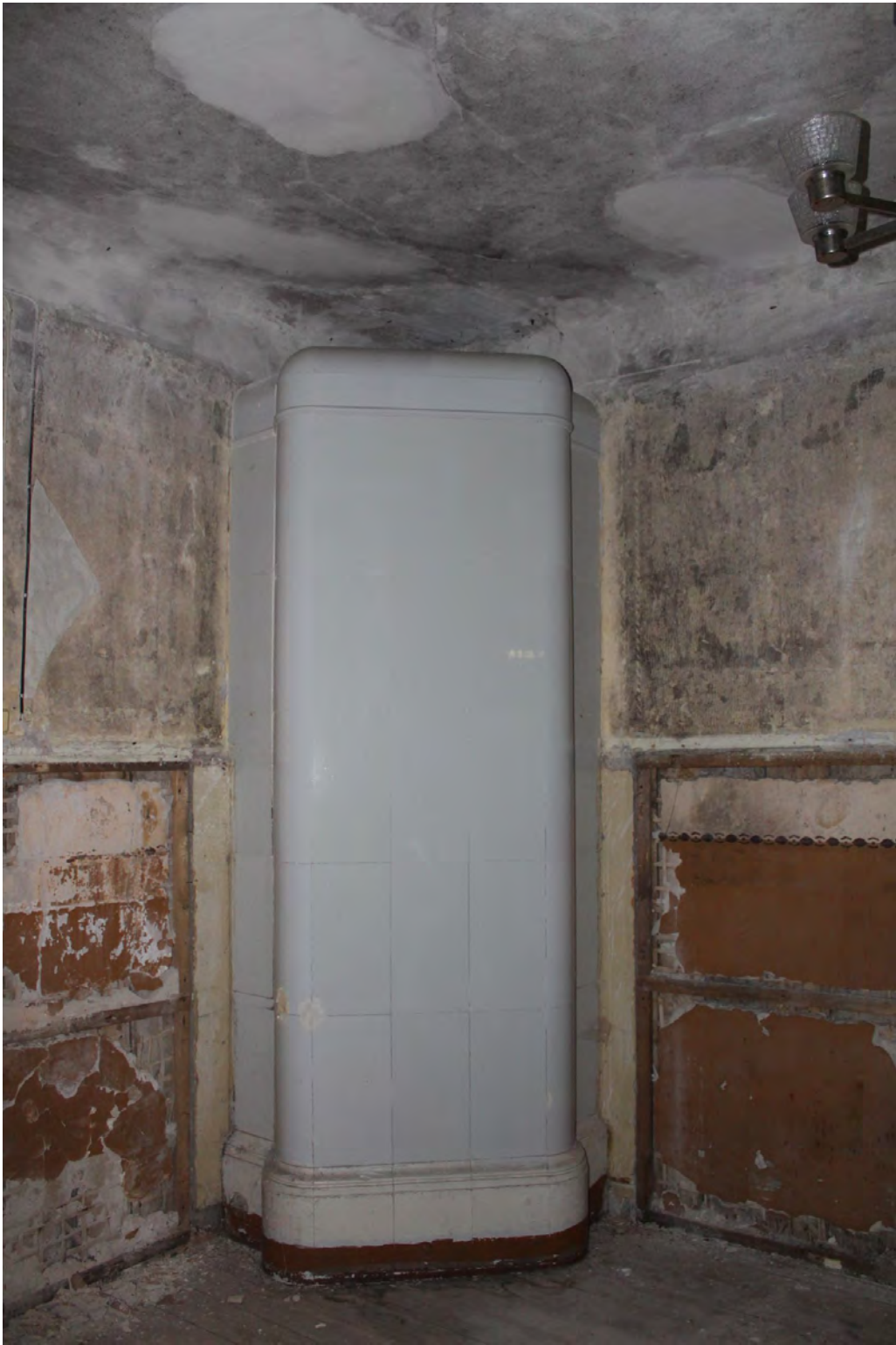
50.att. Podiņu krāsns 2. stāvā.
