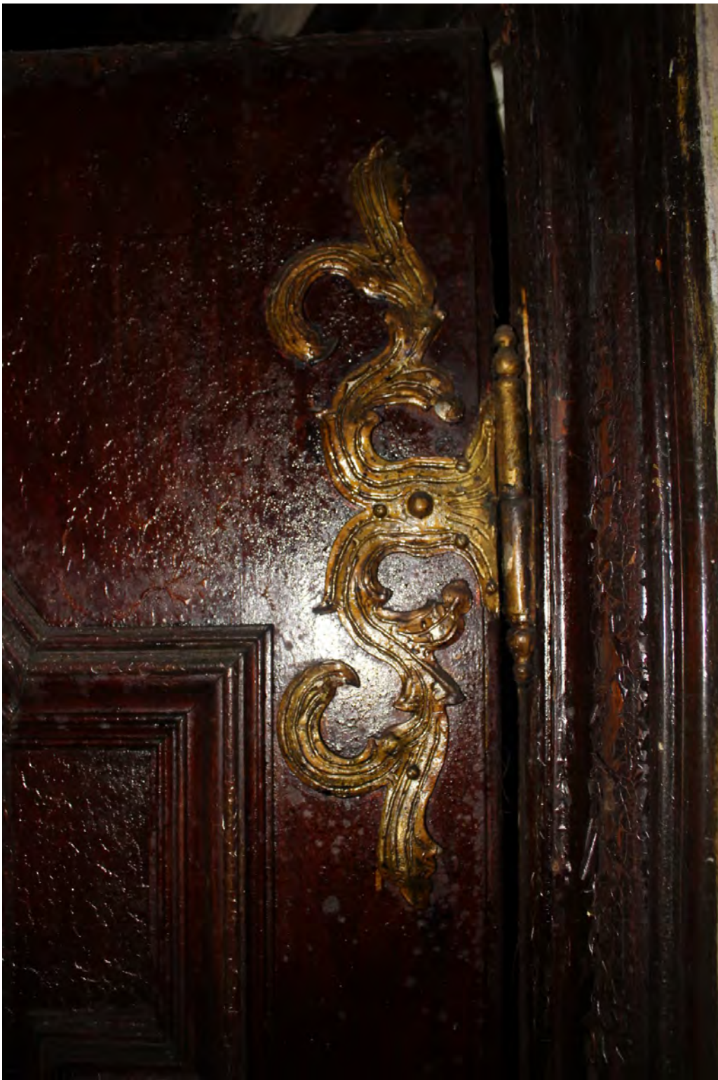
65.att. Durvju metāla apkalums ar viru 2. stāva durvīs.
