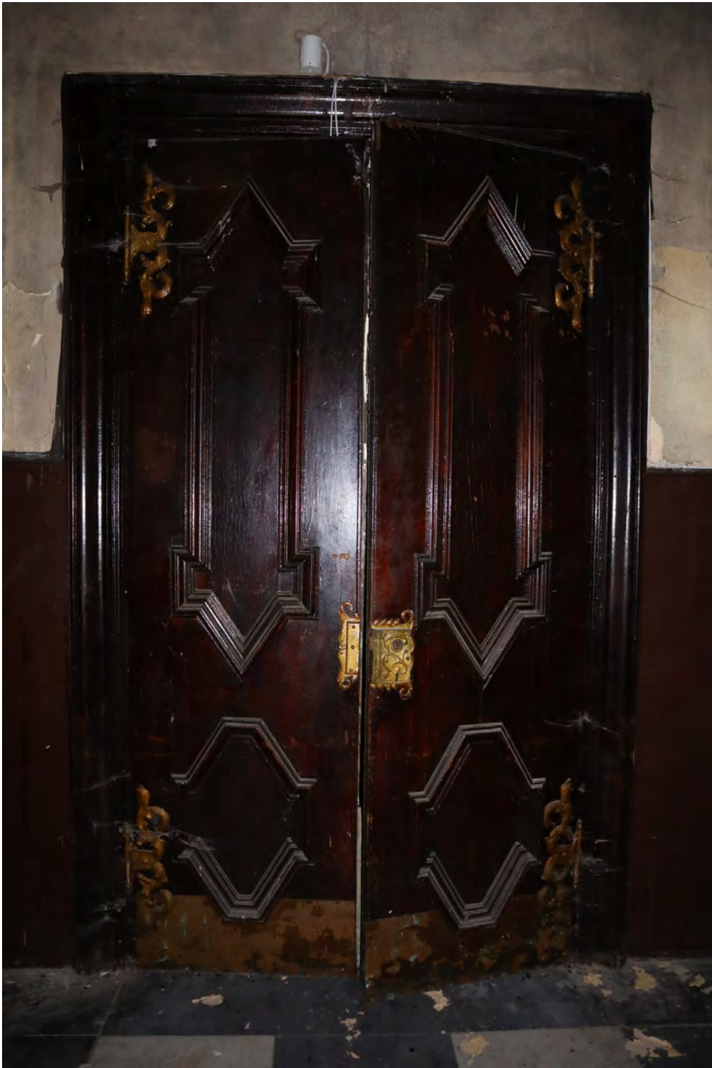
11.att. Sākotnējās divviru iekšdurvis ar atslēgas kārbu 1. stāva telpās.
