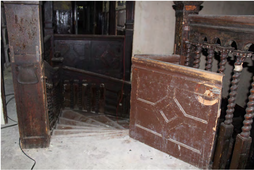
68.att. Kāpņu fragments 2. stāvā.
