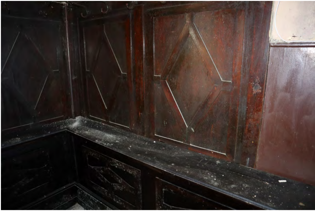
79.att. Koka paneli 1. stāva vestibilā.
