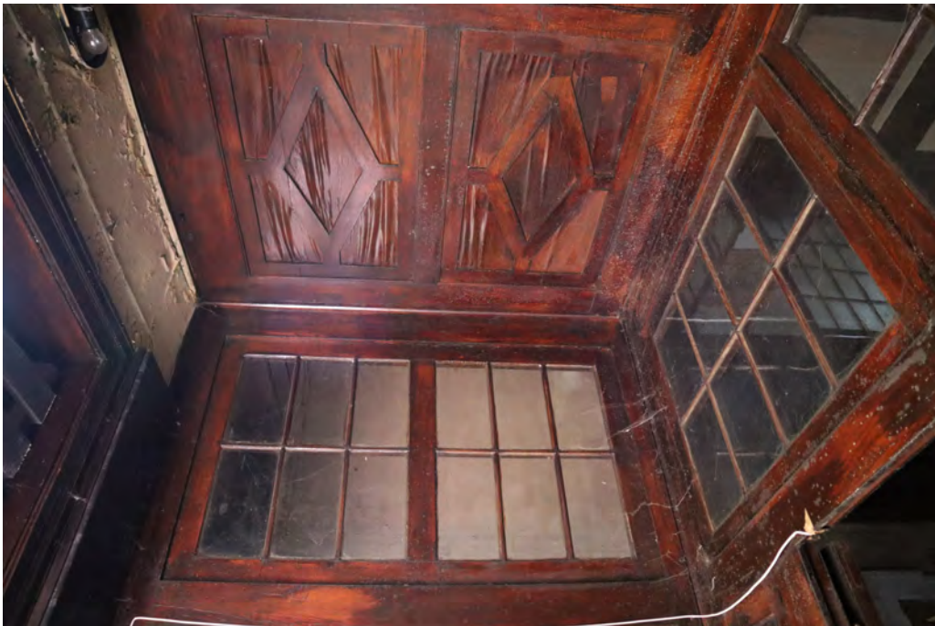
6.att. Vējtvera konstrukcijas fragments ar pārsegumu.
