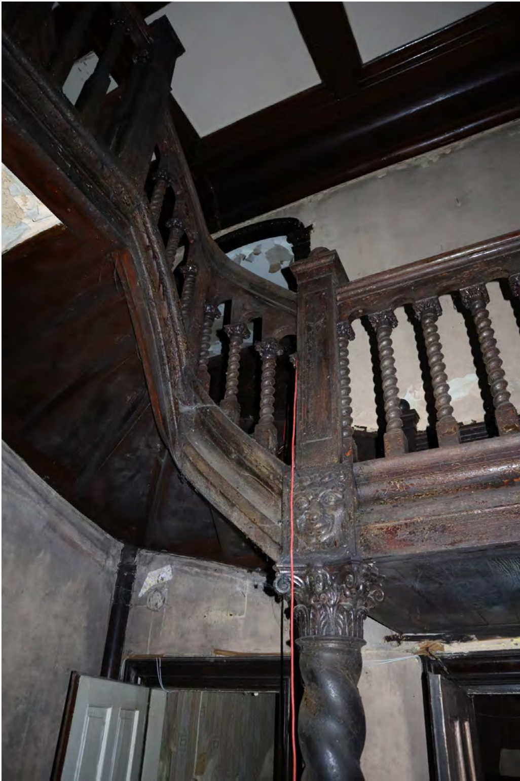
35.att. Kāpņu margas ar maskaronu 1. stāva vestibīlā.
