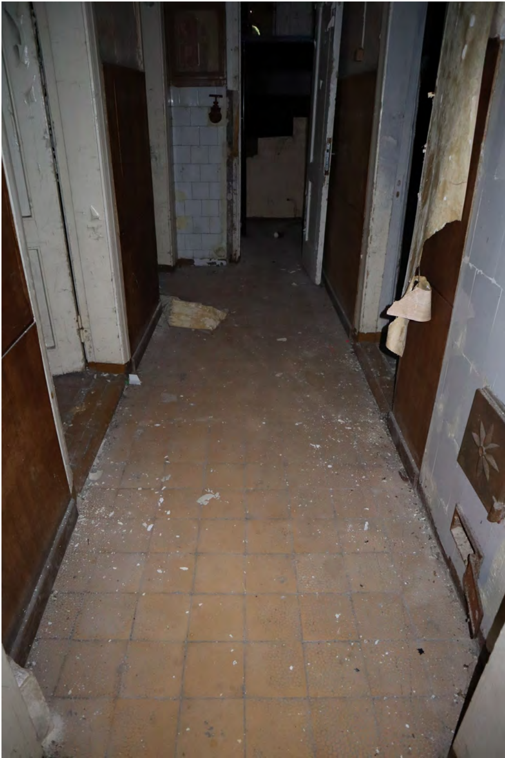
31.att. 1. stāva gaitenis ar vēsturiskajām cementa flīzēm.
