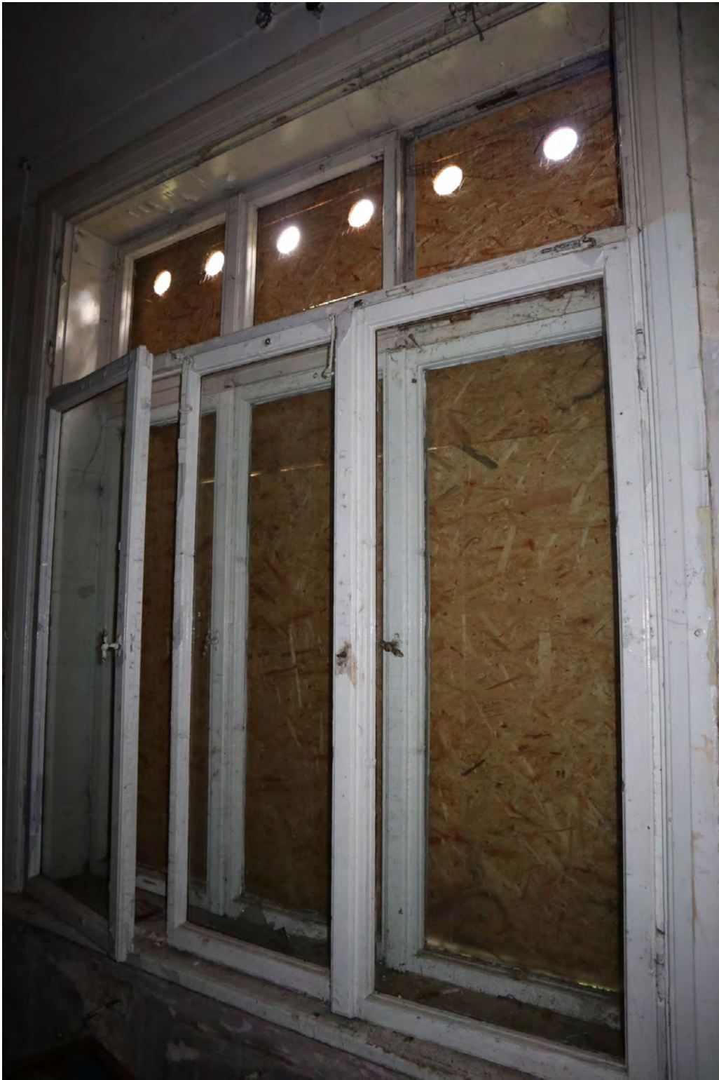
37.att. Iespējams sākotnējie koka logi ar misiņa furnitūru 1. stāva vestibilā.
