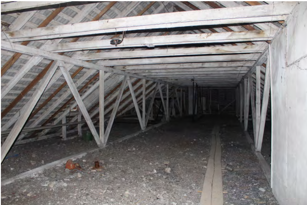
55.att. Bēniņu fragments ar jumta konstrukcijām.
