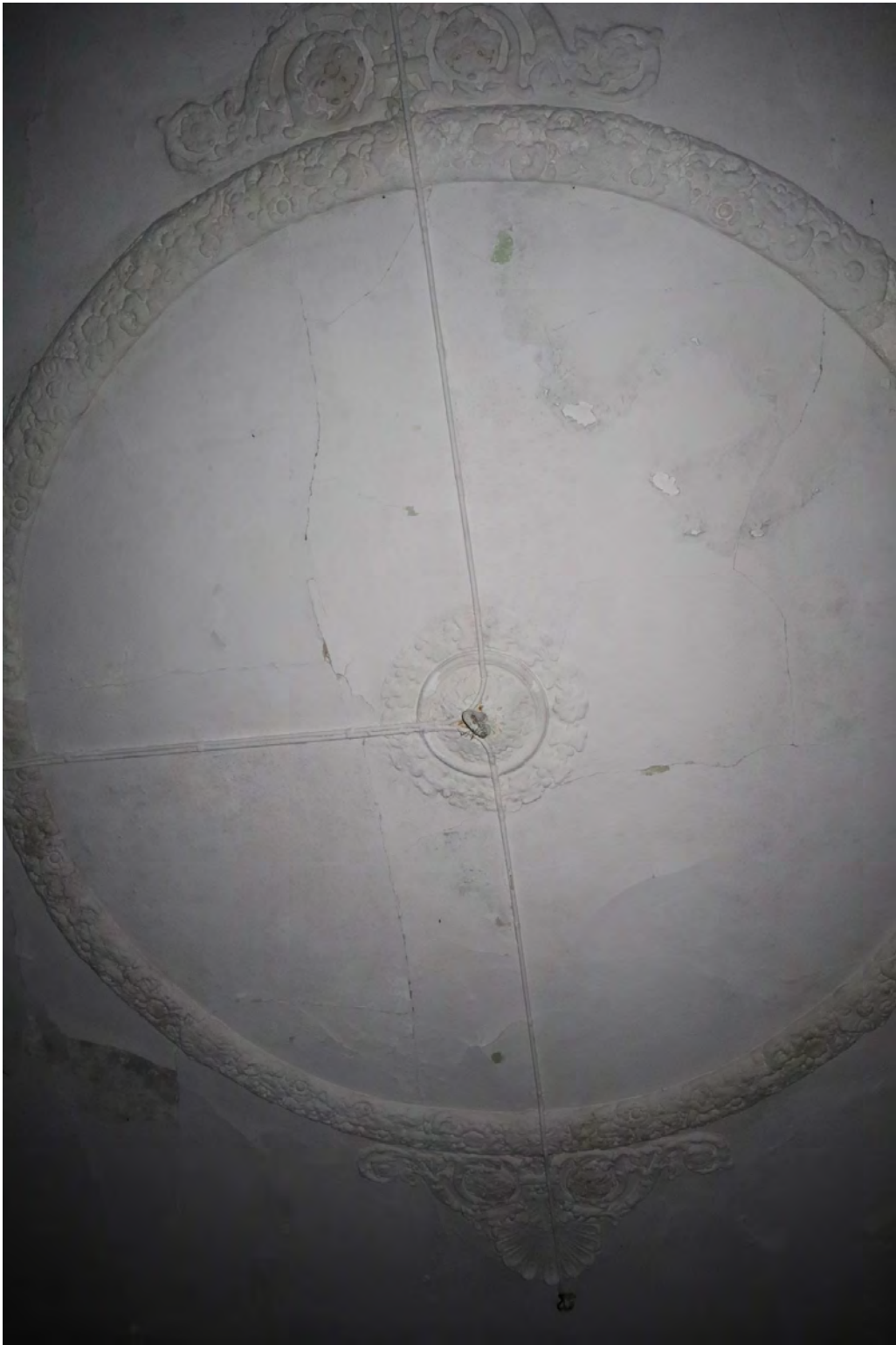
18.att. 1. stāva iekštelpu griestu plafons.
