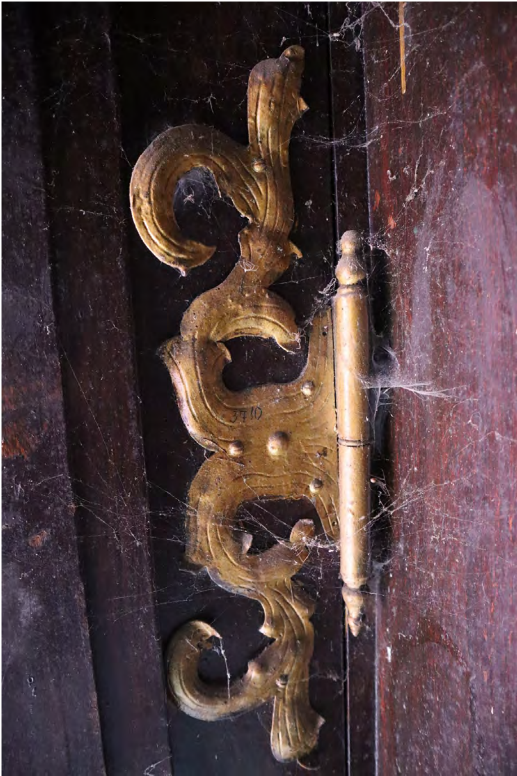
14.att. Ārdurvju vira ar metāla apkalumu.
