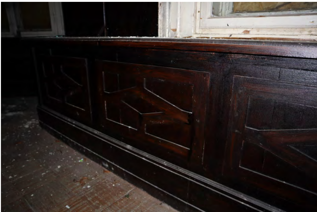
29.att. Koka panelējums zem logiem 1. stāva telpās.
