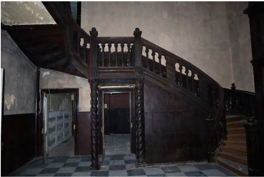
5.att. Koka kāpnes ar vītņu kolonnām 1. stāva vestibilā.
