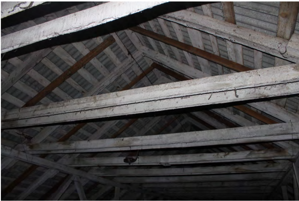
54.att. Bēniņu fragments ar jumta konstrukcijām.
