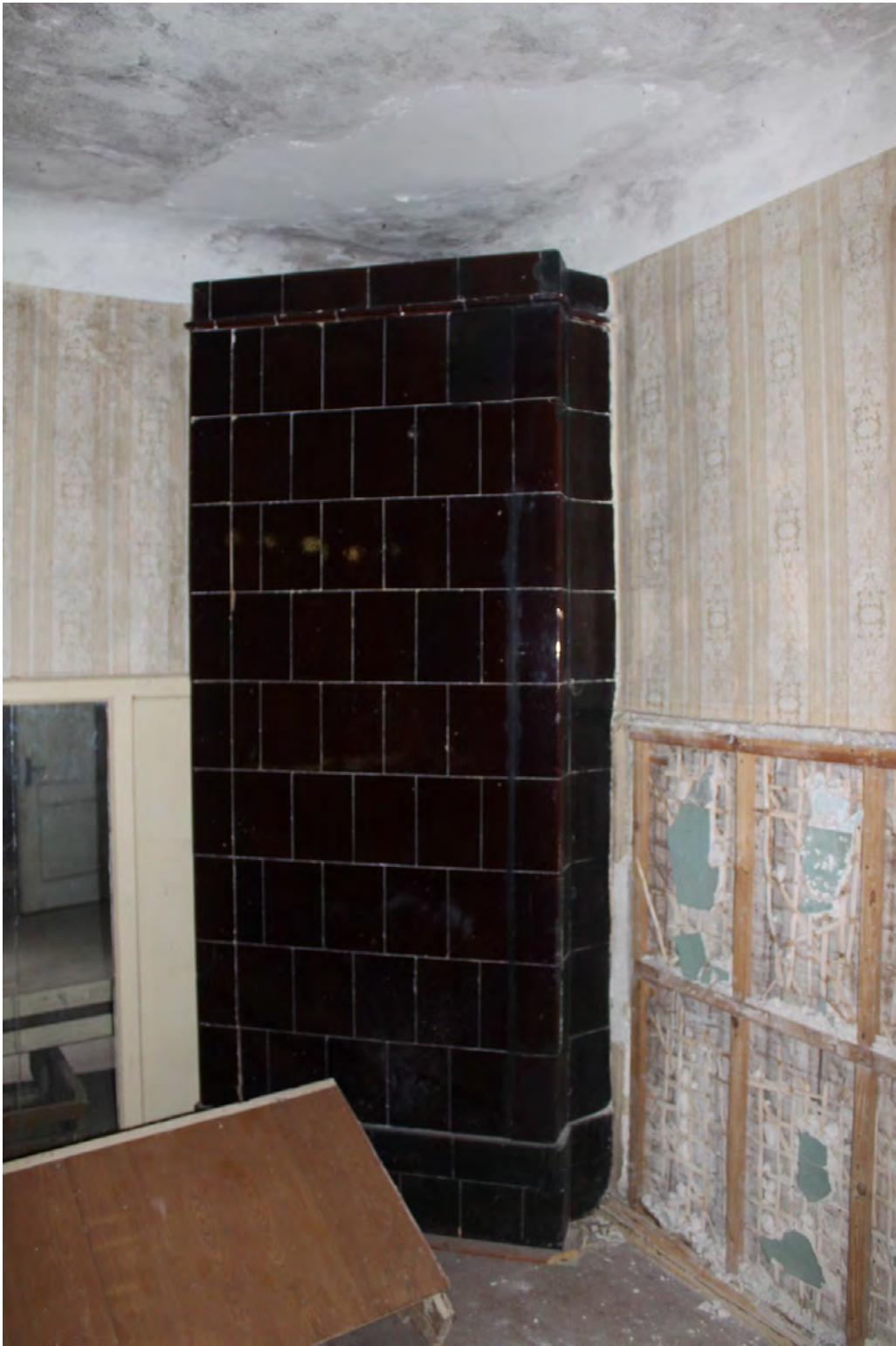
52.att. Podiņu krāsns 2. stāvā.
