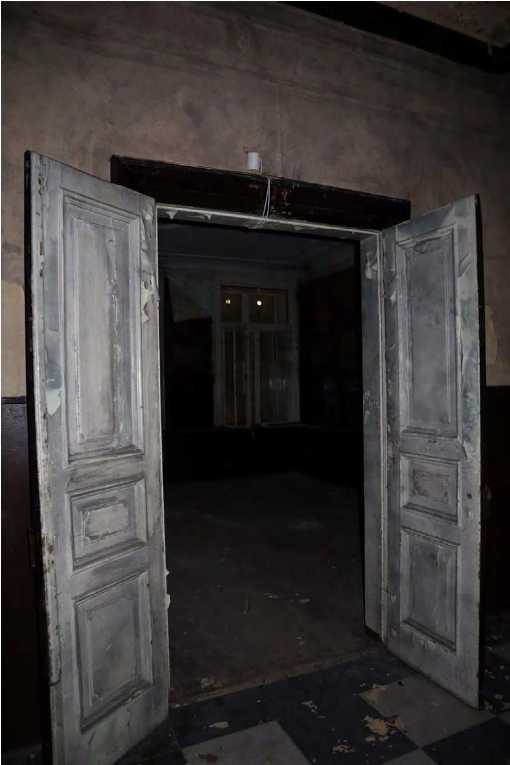
8.att. Sākotnējās iekšdurvis 1. stāva telpās.
