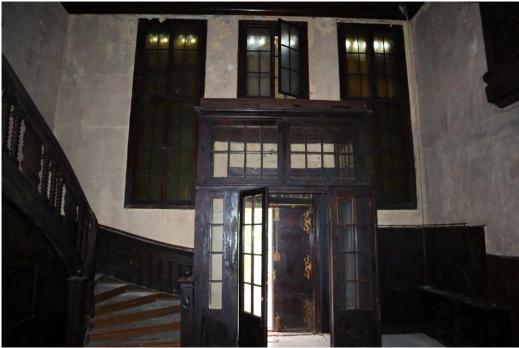
76.att. 1. stāva vestibils ar logiem un vējtveri pret A fasādi.
