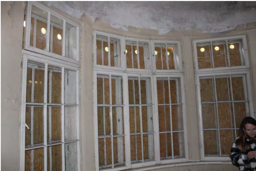
71.att. Koka logi ar rūšu dalījumu un misiņa furnitūru 1. stāva telpās.
