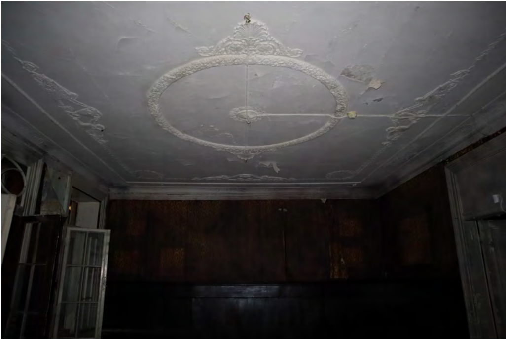
22.att. 1. stāva iekštelpu griestu plafons.
