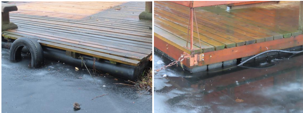
Platforma 1. PVH caurules kā peldošais elements. Kabelis mājiņu apgaismojumam.
