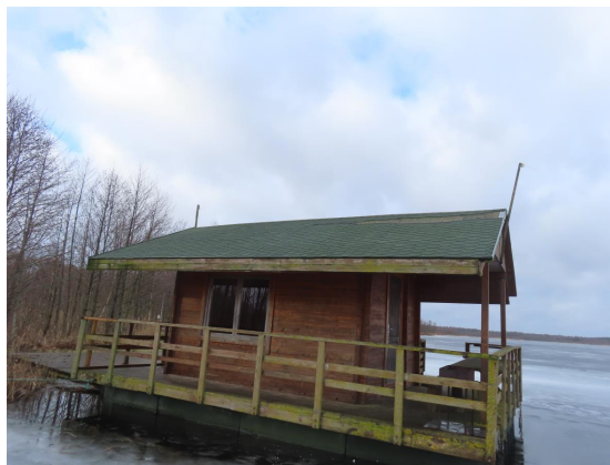
Kempinga mājiņai 1 segums apaudzis ar sūnām. Kempinga mājiņai 2 jumta seguma bojājums.
