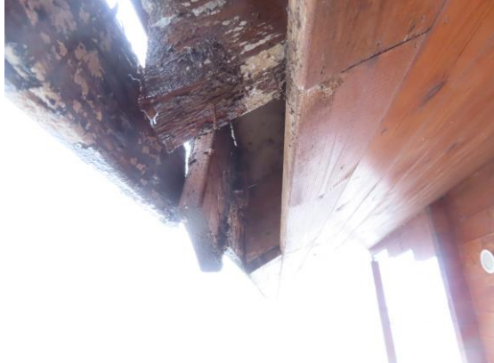
Kempinga mājiņai 1 segums apaudzis ar sūnām. Kempinga mājiņai 2 jumta seguma bojājums.
