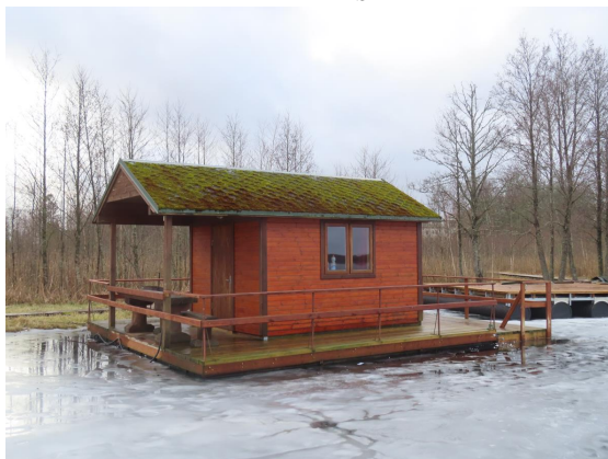
Kempinga mājiņai 1 segums apaudzis ar sūnām. Kempinga mājiņai 2 jumta seguma bojājums.
