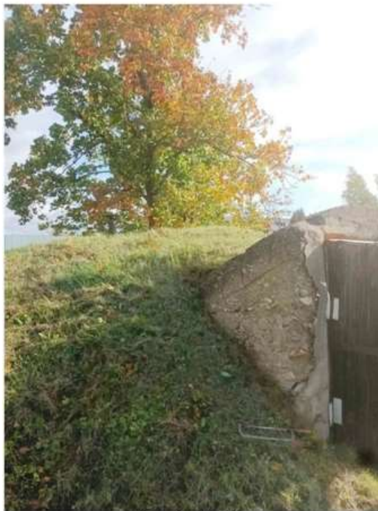
1.att. Apsekotā ēka
