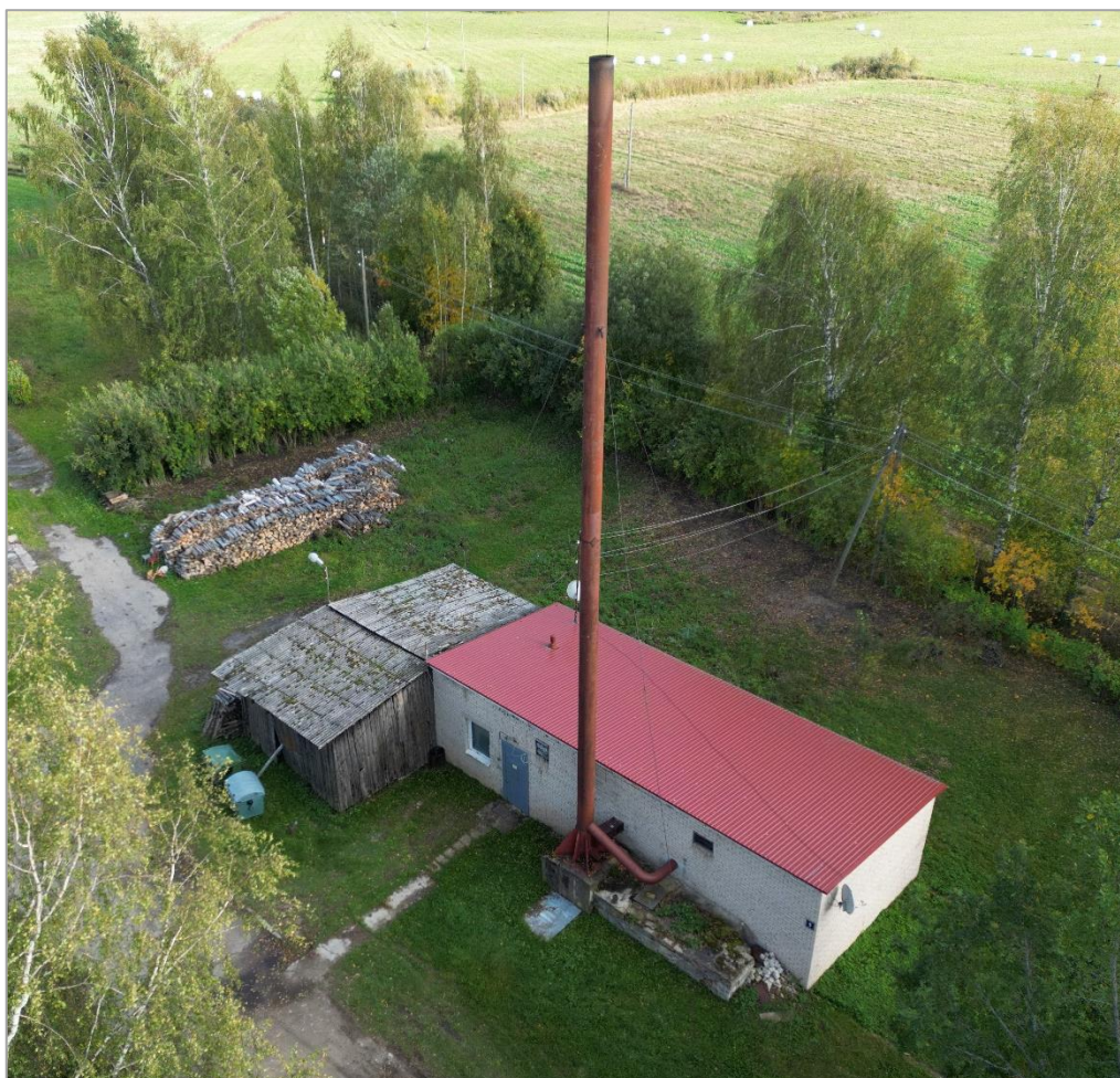
1.att. Apsekotā ēka
