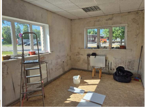
Telpa Nr.3 plānā pirmajā stāvā
