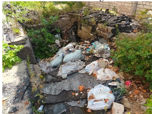
Svaru ēkas (046) bedre pilna ar atkritumiem, t.sk. azbestcements un ruberoīda fragmentiem
