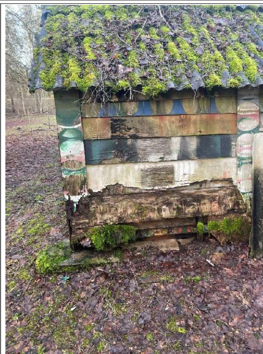
4.1.4 att. Betona pamata bloki
