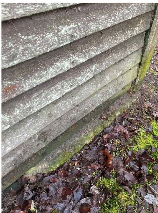
4.1.3 att. Betona pamata bloki
