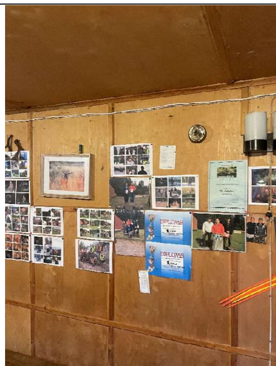
4.15.1 att. Ēkas iekšējā apdare
