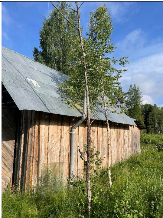
4.8.1 att. Ēkas jumta segums no cinkota skārda
