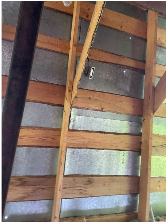
4.8.4 att. Jumta nesošās konstrukcijas ar retinātu dēļu klāju
