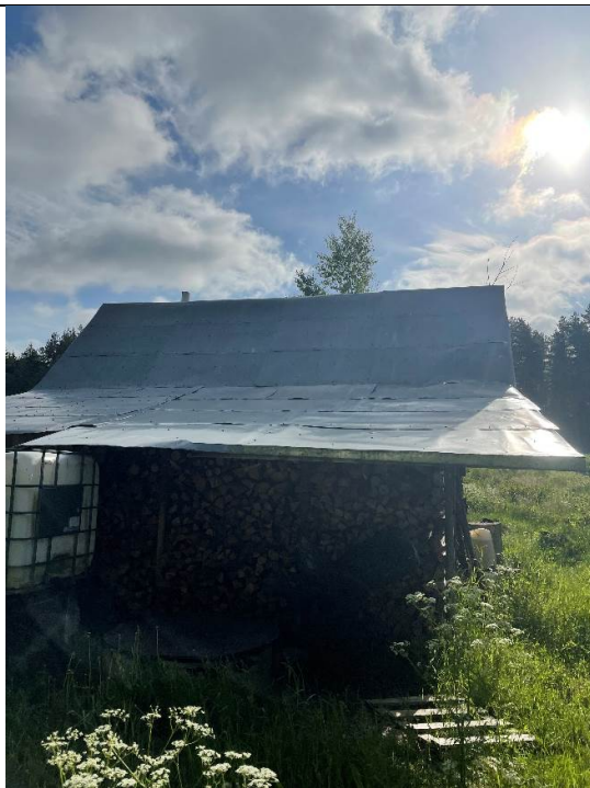
4.8.2 att. Ēkas jumta segums no cinkota skārda
