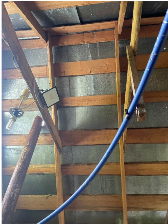
4.8.3 att. Jumta nesošās konstrukcijas ar retinātu dēļu klāju
