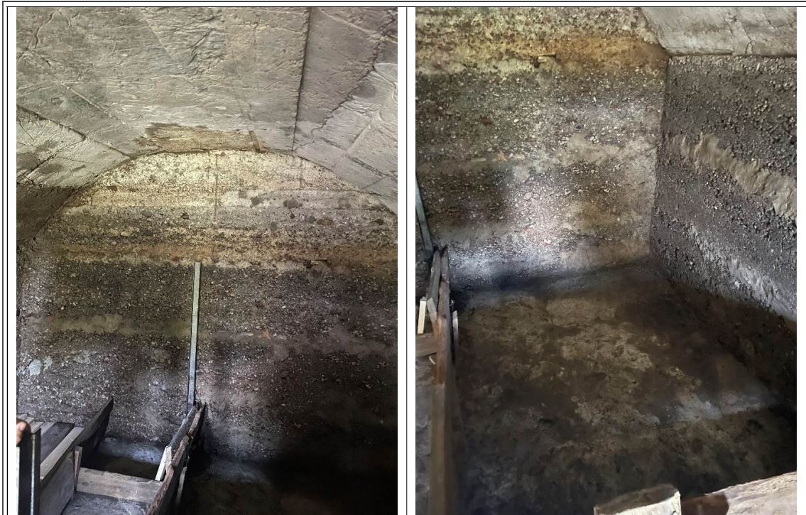
4.1.1 att. Nesošā siena no betona
