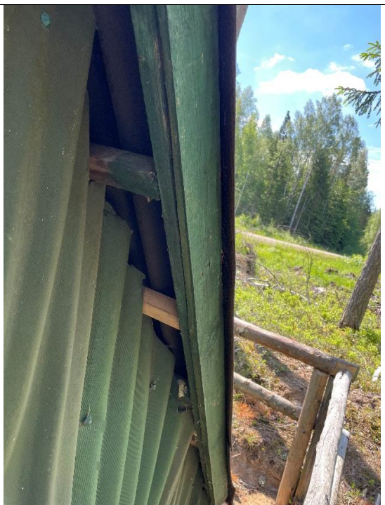
4.8.3att. Jumta latojums
