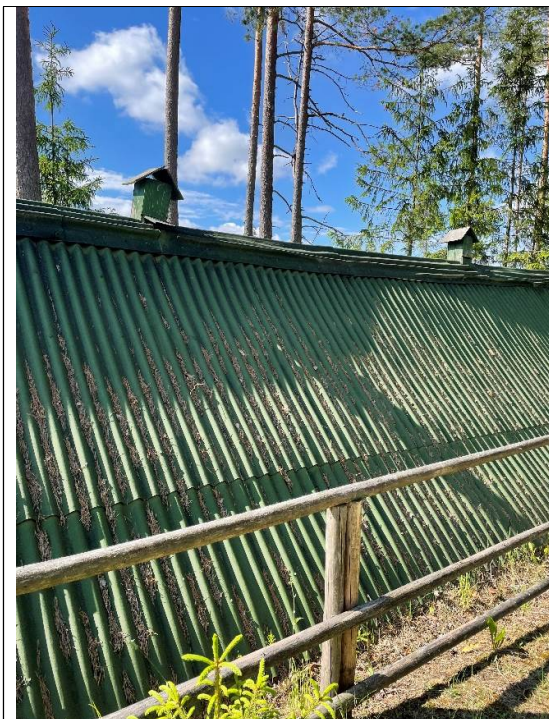
4.8.1att. “Onduline” jumta segums
