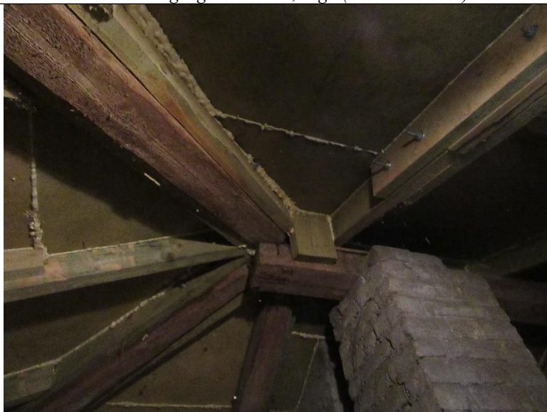
10.att.: Daugavgrīvas iela 2, Rīga (jumta konstrukcija)
