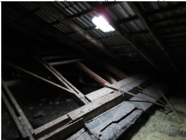
11.att.: Daugavgrīvas iela 2, Rīga (jumta konstrukcija)
