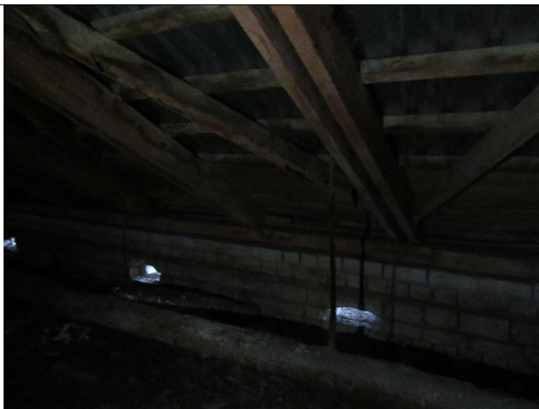
12.att.: Daugavgrīvas iela 2, Rīga (jumta konstrukcija)
