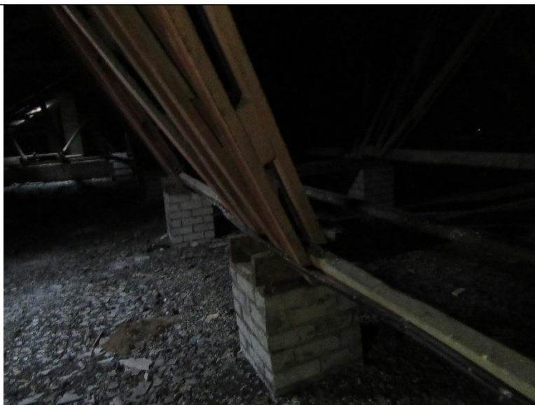
12.att.: Sētas iela 1, Rīga (jumta konstrukcija)
