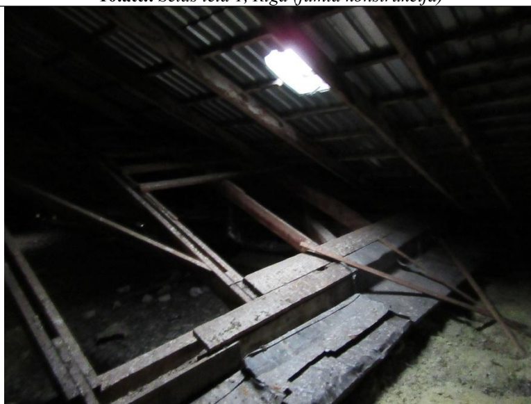
11.att.: Sētas iela 1, Rīga (jumta konstrukcija)
