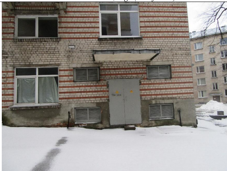
8.att.: Sētas iela 1, Rīga (fasāde)
