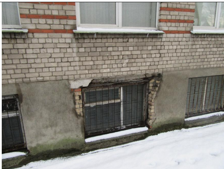
6.att.: Sētas iela 1, Rīga (ailas pārsedze)
