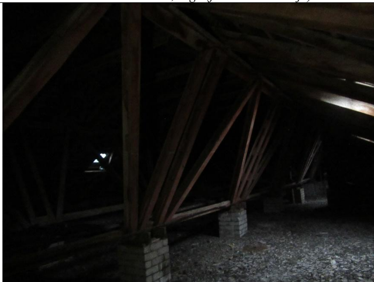
13.att.: Sētas iela 1, Rīga (jumta konstrukcija)
