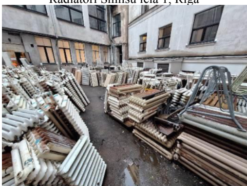
Radiatoru Smilšu ielā 1, Rīgā
