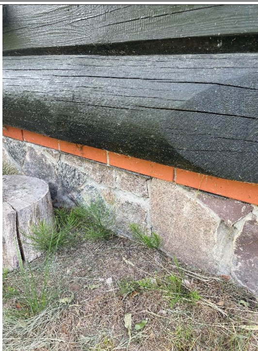
4.5.2 att. Horizontālā hidroizolācija no bitumena ruļļveida materiāla
