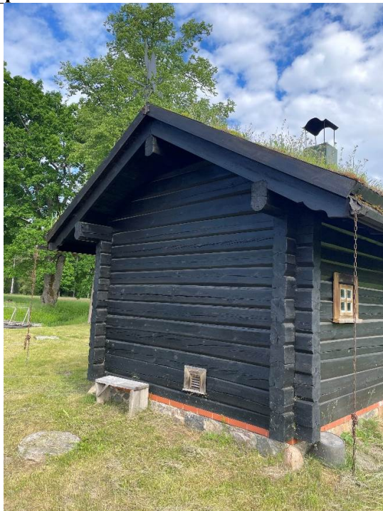
4.2.1 att. Nesošā koka konstrukcija no brusām
