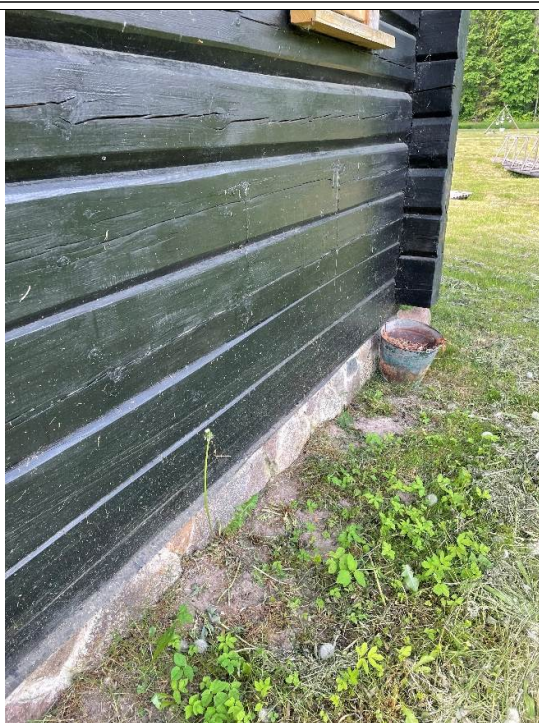
4.5.1 att. Horizontālā hidroizolācija no bitumena ruļļveida materiāla
