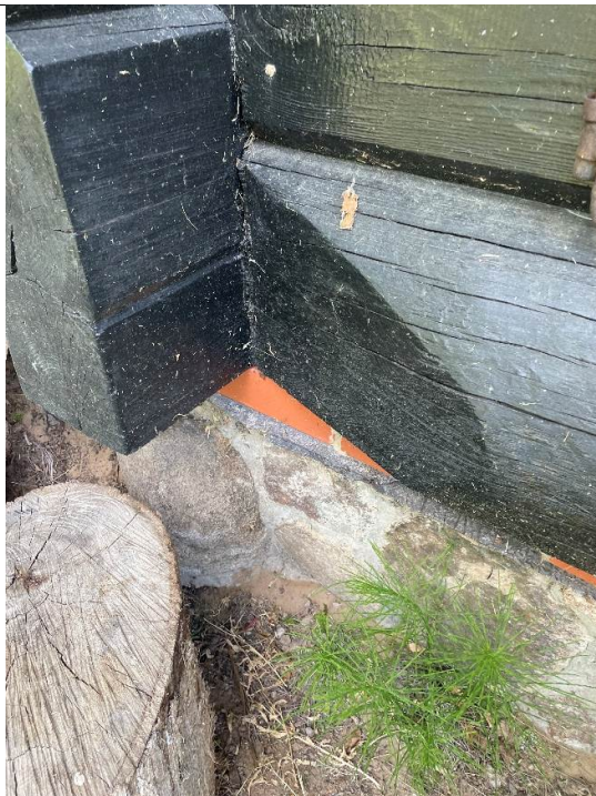
4.2.2 att. Nesošā koka konstrukcija no brusām
