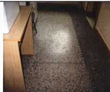
101. att. Slīpēts betona klons
