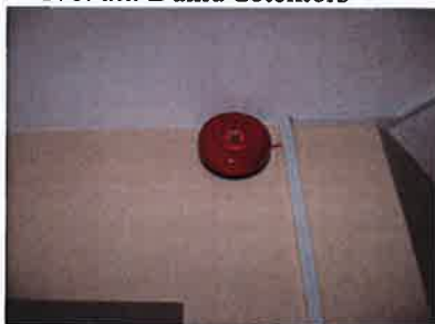
180. att. Trauksmes izziņošanas signalizatori
