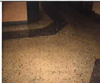
100. att. Slīpēts betona klons
