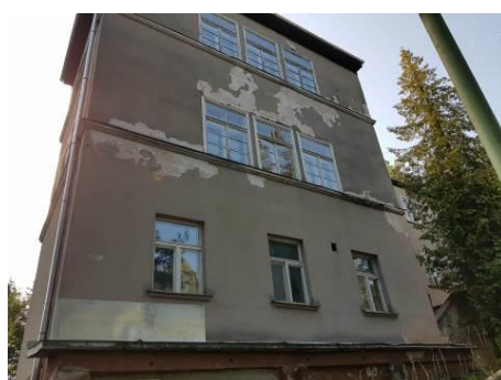
2.2.5. att. Apsekotā ēka, ziemeļrietumu fasāde
