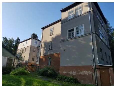
2.2.2. att. Apsekotā ēka, ziemeļaustrumu fasāde
