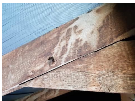
4.8.1.5. att. Jumta nesošo konstrukciju savienojums ar koka tapu
