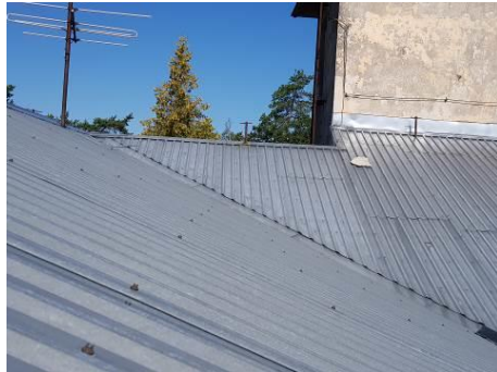
4.8.2.1. att. Skats uz jumta segumu
