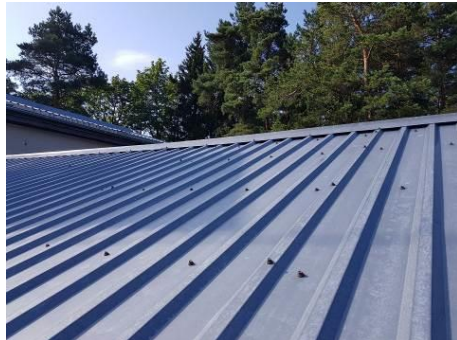
4.8.2.3. att. Skārda loksnes un esošā seguma savienojums
