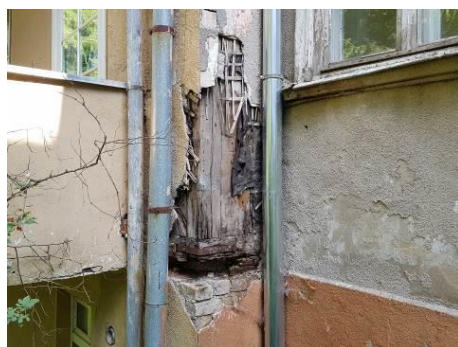
4.9.2.3. att. 2. stāva lodžija
