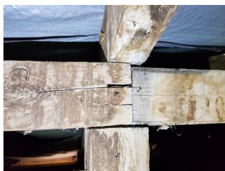
4.8.1.4. att. Skats uz jumta nesošajām konstrukcijām
