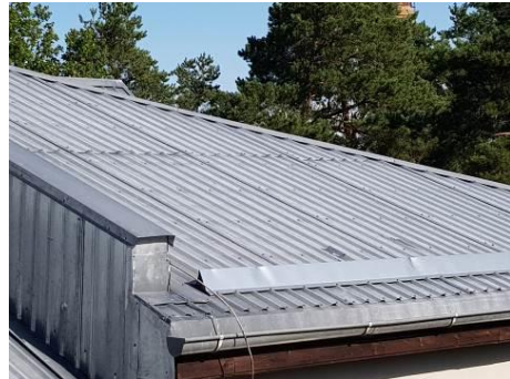
4.8.2.2. att. Skats uz jumta segumu
