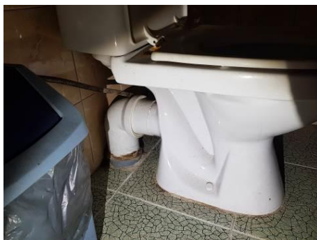
5.1.2.2. att. Klozetpoda pievienojums ar PVC caurulēm
