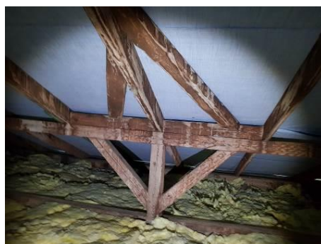
4.8.1.2. att. Skats uz jumta nesošajām konstrukcijām
