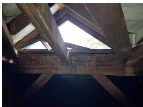
4.8.1.3. att. Skats uz jumta nesošajām konstrukcijām
