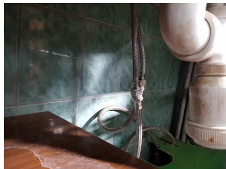
5.1.1.6. att. Sanitārtehniskās iekārtas pieslēgums ar lokano pievadu
