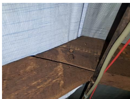
4.8.1.6. att. Jumta nesošo konstrukciju savienojums ar koka tapu un metāla naglām
