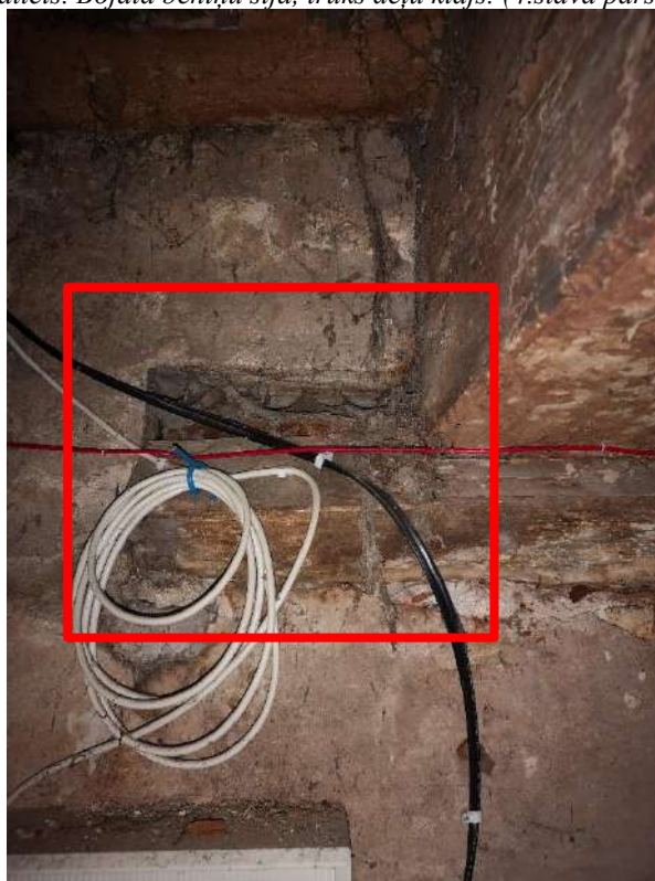
11.e. Redzams, ka esošā mūrlata zem 4.stāva pārseguma sijas ir saspiesta.
