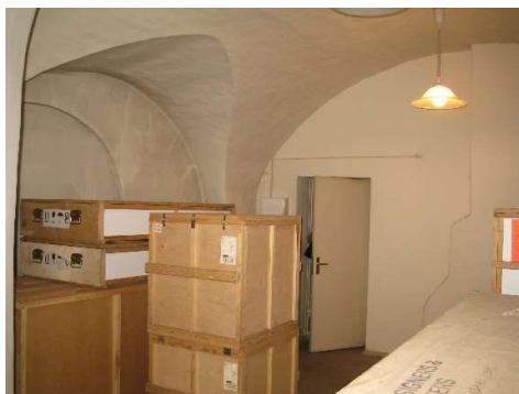
Bijušais siltummezgls 1.stāvā
