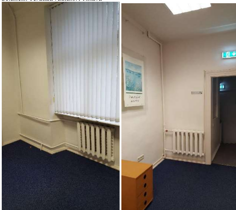
51.attēls. Čuguna radiatori bez termoregulatoriem
