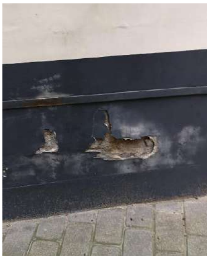
32.attēls. Ārējās apdares apmetuma bojājums
