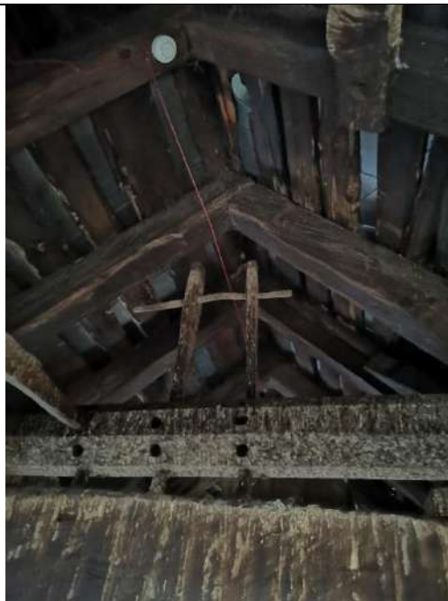
13. attēls. Koka spāru balstījums korē (stāvoklis labs);
