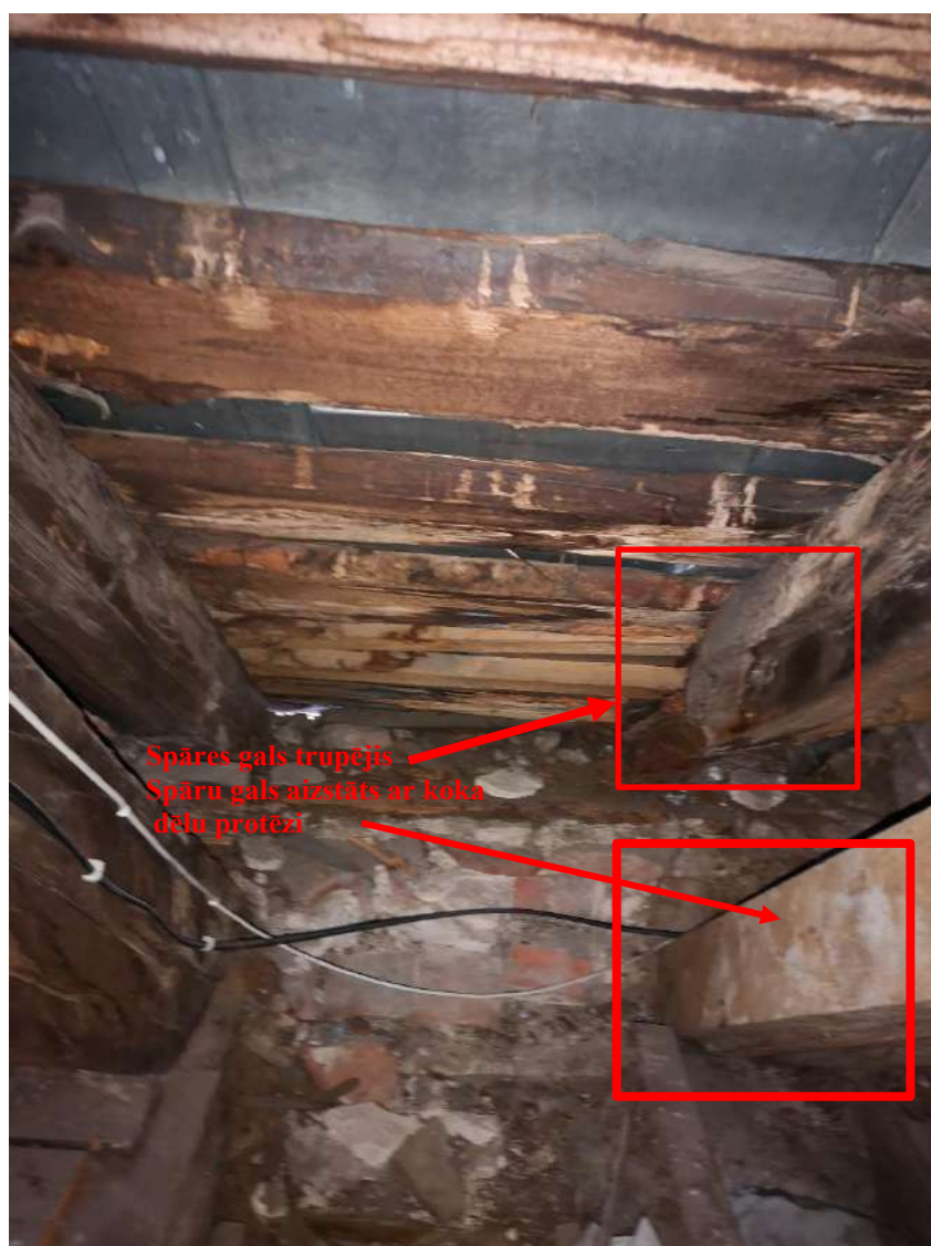
14. attēls Koka jumti. Spāru balstvietas (nesošā konstrukcija)
