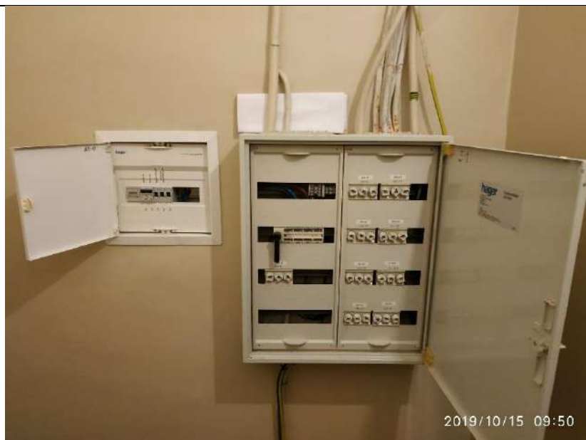
60.attēls. Ēkas galvenā un grupu sadalne.
