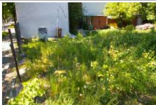
Būves pamati ar kadastra apzīmējumu 1700 040 0289 001
