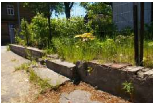
Būves pamati ar kadastra apzīmējumu 1700 040 0289 001
