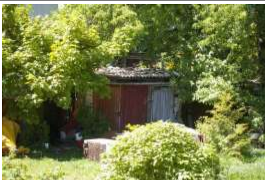
Liepājas pilsētas zemesgrāmatas nodaļumā Nr.3870-1 neregistrēta Būve ar kadastra apzīmējumu 1700 040 0289 005
