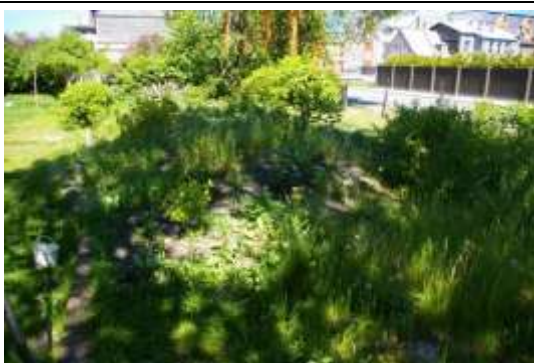
Būves pamati ar kadastra apzīmējumu 1700 040 0289 001
