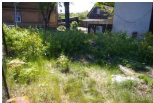
Būves pamati ar kadastra apzīmējumu 1700 040 0289 001
