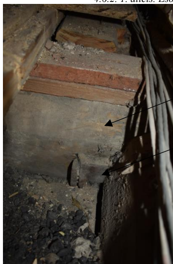
4.6.2. 2. attēls. Esošā pārseguma sija (atsegums)
