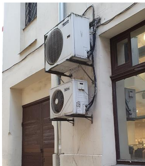
5.6.1.10.attēls. Dzesēšanas ārējie bloki piekarināti pie pagalmu fasādes, kas apkalpo 1.stāva telpas
