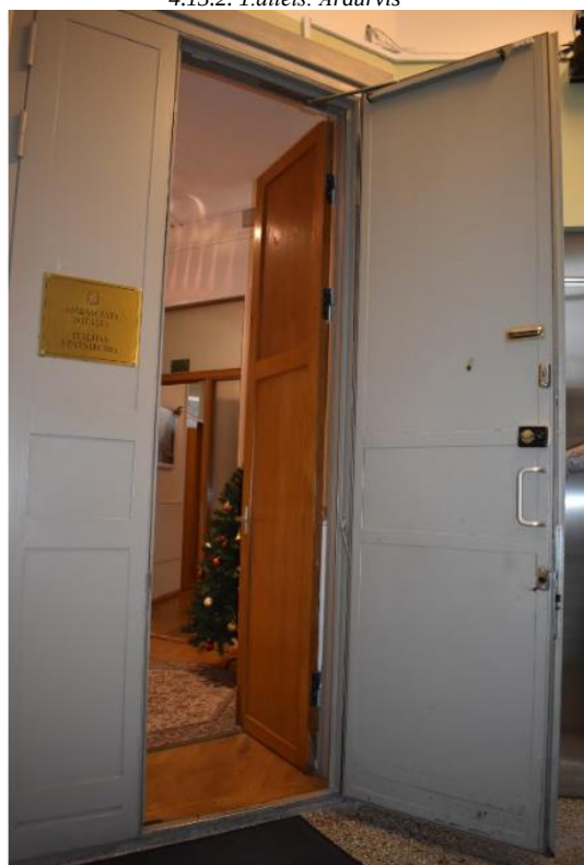
4.13.2. 2.attēls. Divvīru metāla iekšdurvis uz kāpņu telpu.
