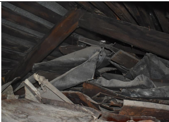
4.8.1. 5.attēls. Spāru galu savienojums kore (uz bēniņu pārseguma atstāts vecais metāla lokšņu jumta segums).
