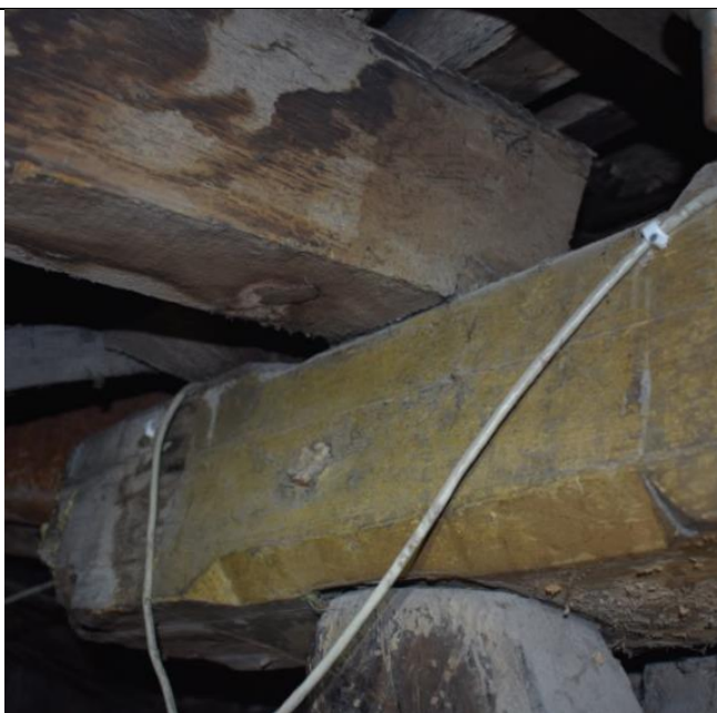
4.8.1. 2.attēls. Savienojuma mezgls ar iecirtumu(spāre brīvi balstīta uz koptura)
