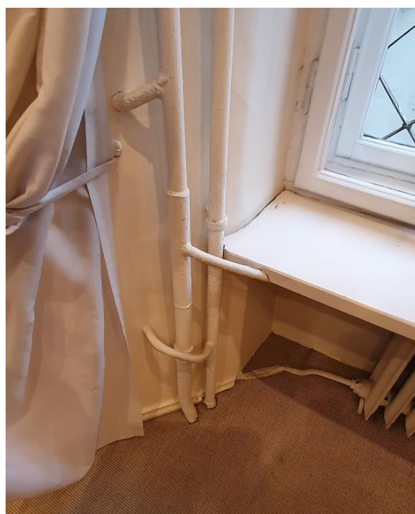
5.5.1.6.attēls. Radiatora pievienojums pie stāvvada
