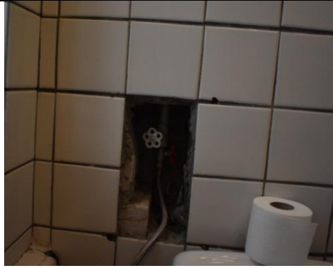
4.18.1. 4. attēls. Flīžu sienu apdare (3.stāvs wc telpa)
