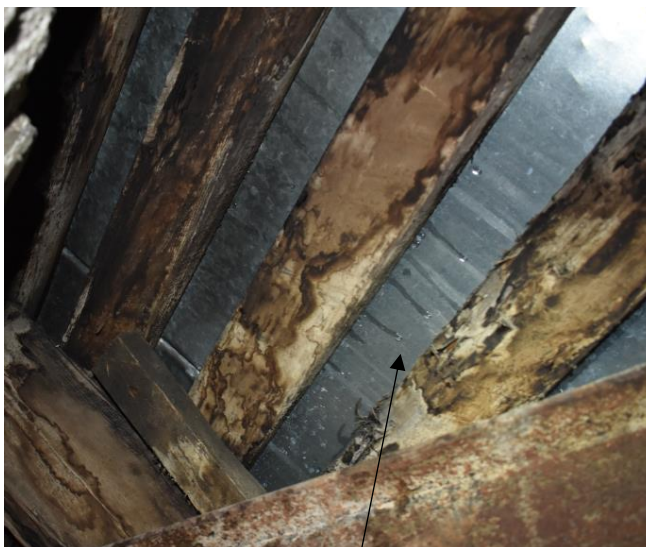
4.8.1. 4.attēls. Redzams kondensāts starp skārda un koka latojumu.
