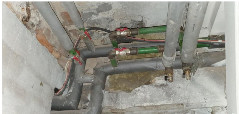
5.4.1.4.attēls. Apkures cauruļvadu sadalījums pagrabā
