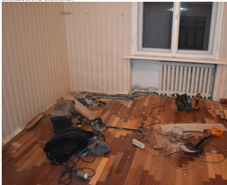
4.6.2. 1. attēls. Esošā pārseguma atsegums
