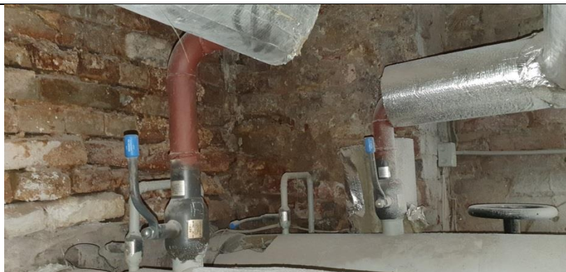
5.4.1.3.attēls. Cauruļvadu pievienojums pie siltumtrases
