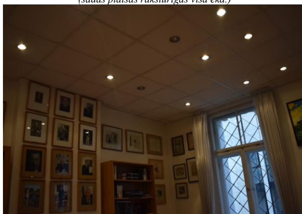
4.18.1.9. attēls. Piekārtie griesti (3.stāvs)
