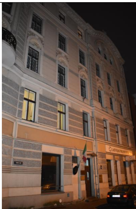
4.2.3. 5. attēls.. fasāde Nr.1
