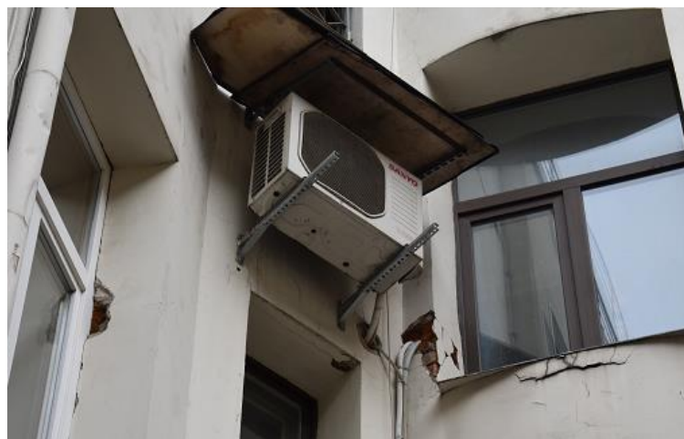
5.6.1.9.attēls. Dzesēšanas ārējais bloks piekarināts pie pagalmu fasādes
