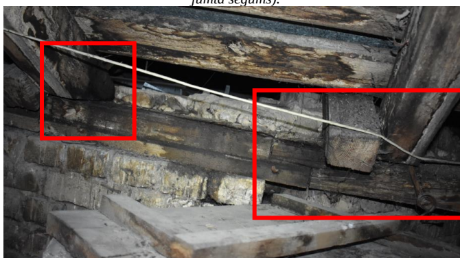
4.8.1. 6.attēls. Paaugstināta mitruma radīti bojājumi spāres gals un mūrlata vietā, kur veidots stīķis.
