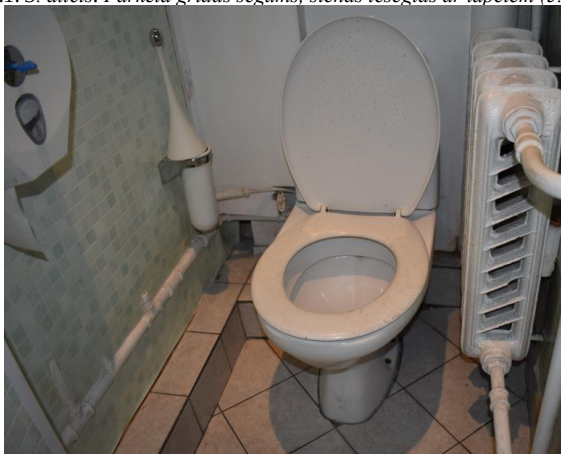
4.18.1. 4. attēls. Flīžu grīdas un sienu apdare (5.stāvs wc telpa)
