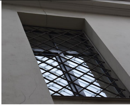
4.2.5. 1. attēls. Pamatu sēšanās plaisa ķīļveida pārsedzē.
