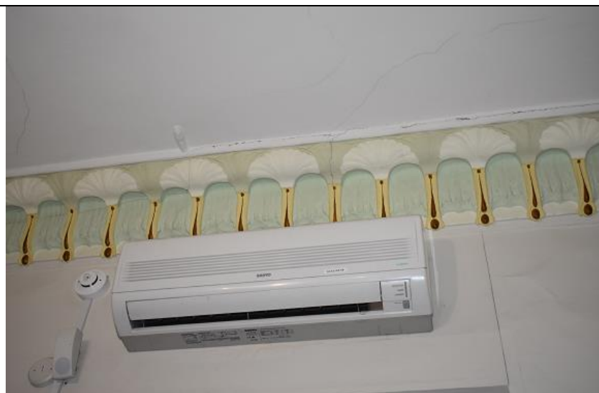
5.6.1.8.attēls. Lokāla dzesēšana atsevišķās telpās. Ārējais bloks atrodas pagalmu pusē, skat.5.6.1.9.att
