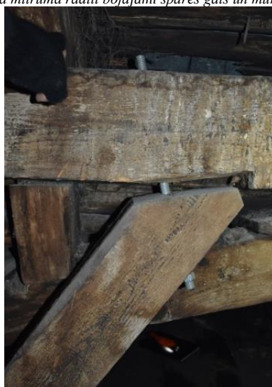
4.8.1. 6.attēls. Atgāznis atdalījies no koptura bojāts savienojuma mezgls
