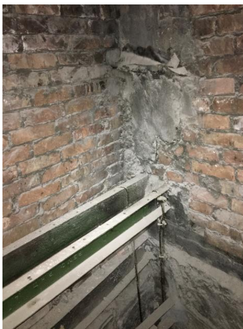
4.2.4. 3.attēls. Lifta šahtas nesošās iekšsienas
