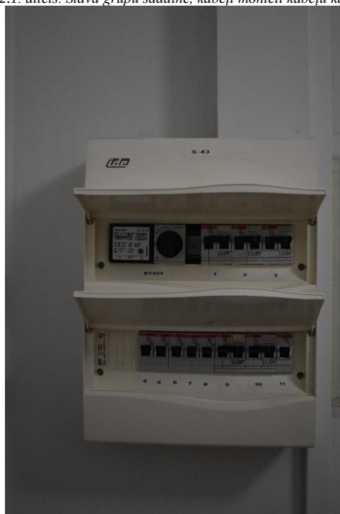
5.9.2.1. attēls. Grupu sadalne, aprīkota ar noplūdstāvēšanas automātiem datortehnikas barošanai.
