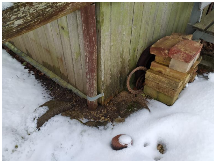
F-3. Nav izbūvēta aizsargapmale
