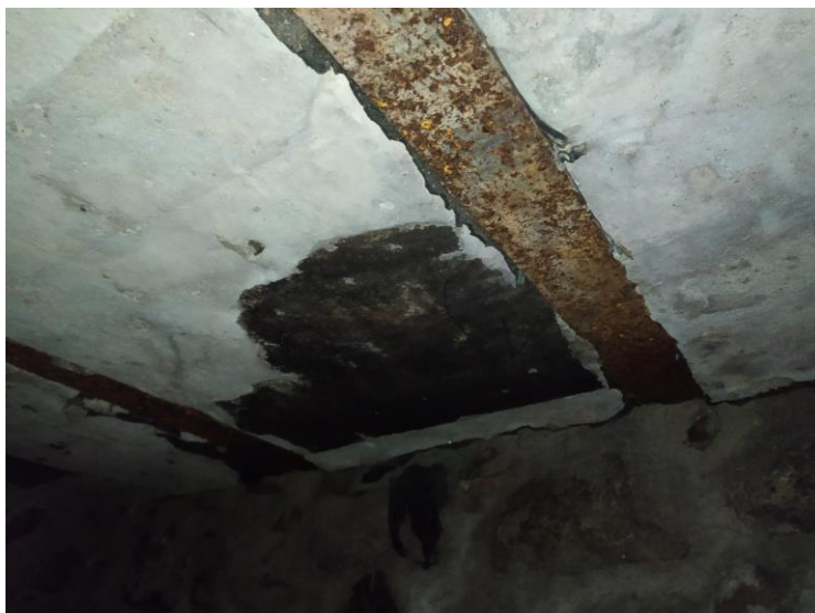
F-7. Pagraba metāla sija virspusēji korodējusi
