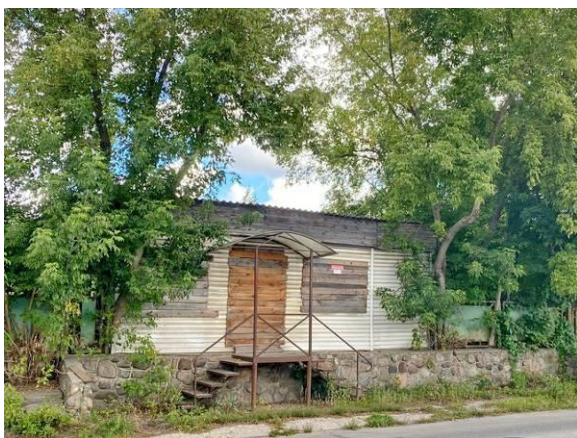
Skats uz ēku 003 no Nometņu ielas puses
