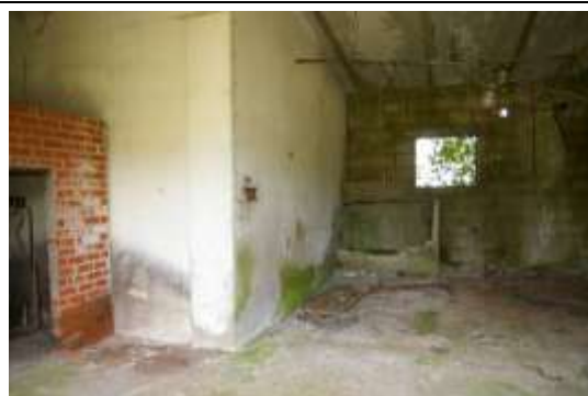
Būve (svaru māja) ar kadastra apzīmējumu 6468 003 0065 005
