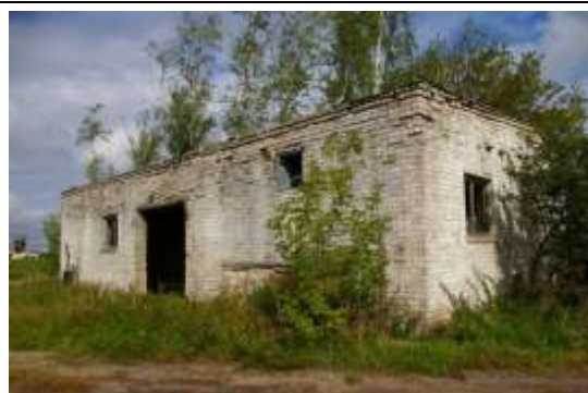
Būve (svaru māja) ar kadastra apzīmējumu 6468 003 0065 005
