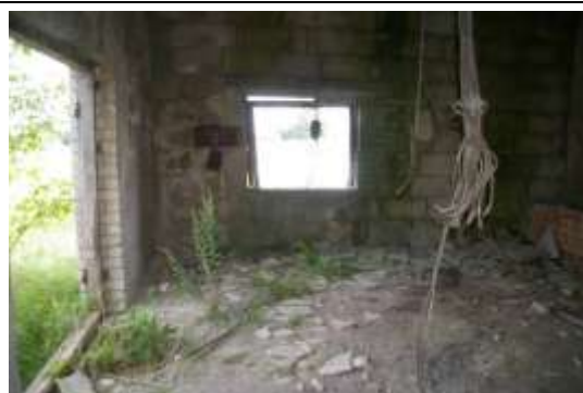
Būve (svaru māja) ar kadastra apzīmējumu 6468 003 0065 005
