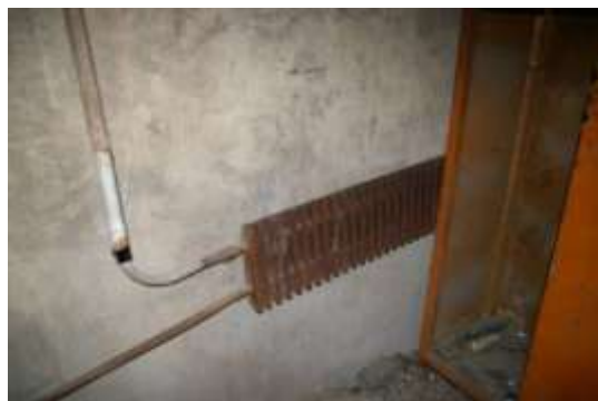
Būve (svaru māja) ar kadastra apzīmējumu 6468 003 0065 005
