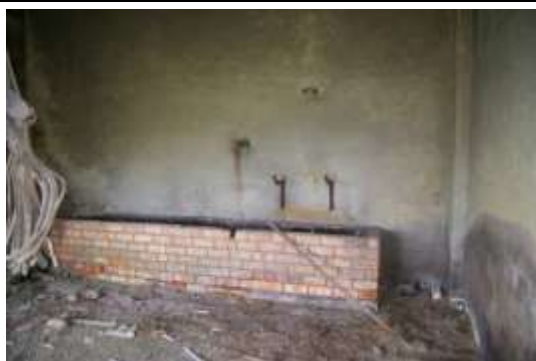
Būve (svaru māja) ar kadastra apzīmējumu 6468 003 0065 005
