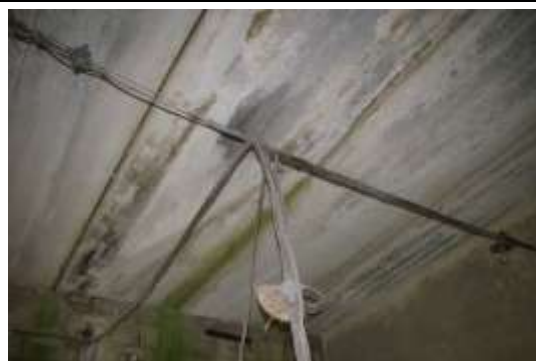
Būve (svaru māja) ar kadastra apzīmējumu 6468 003 0065 005
