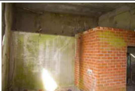
Būve (svaru māja) ar kadastra apzīmējumu 6468 003 0065 005
