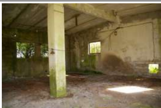
Būve (svaru māja) ar kadastra apzīmējumu 6468 003 0065 005
