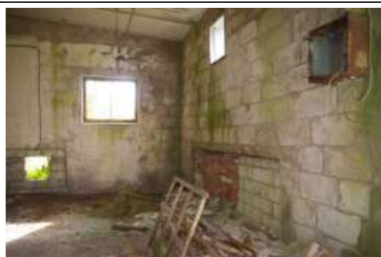
Būve (svaru māja) ar kadastra apzīmējumu 6468 003 0065 005
