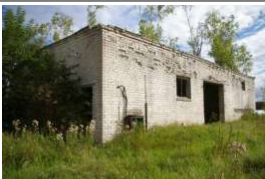
Būve (svaru māja) ar kadastra apzīmējumu 6468 003 0065 005
