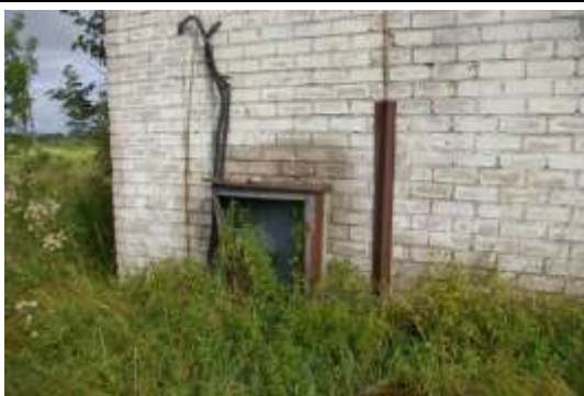
Būve (svaru māja) ar kadastra apzīmējumu 6468 003 0065 005
