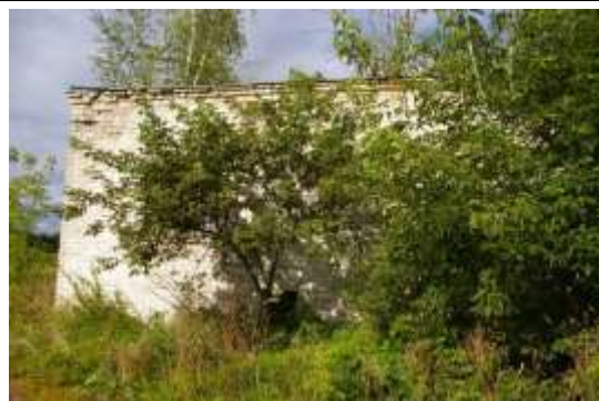
Būve (svaru māja) ar kadastra apzīmējumu 6468 003 0065 005
