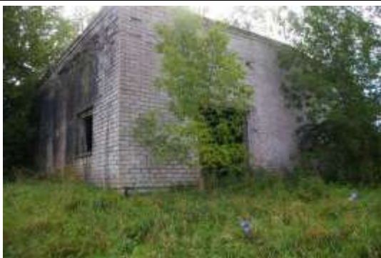
Būve (svaru māja) ar kadastra apzīmējumu 6468 003 0065 005
