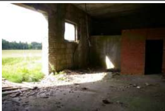
Būve (svaru māja) ar kadastra apzīmējumu 6468 003 0065 005
