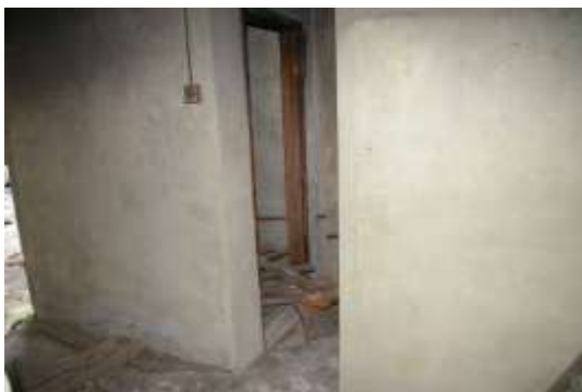
Būve (svaru māja) ar kadastra apzīmējumu 6468 003 0065 005
