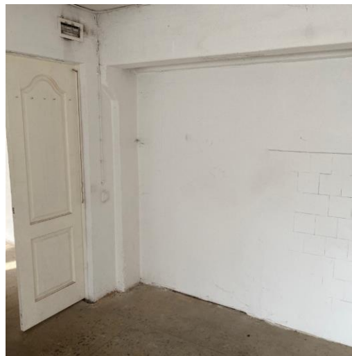
15. att. Karkasa konstrukcijas
