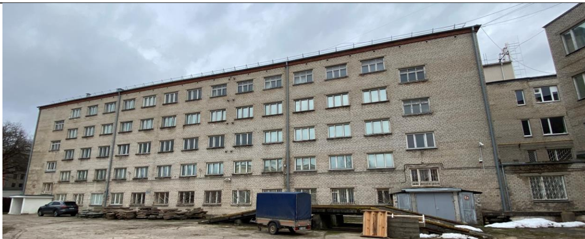
11. att. Ēkas pagalma puses (ZR) fasāde
