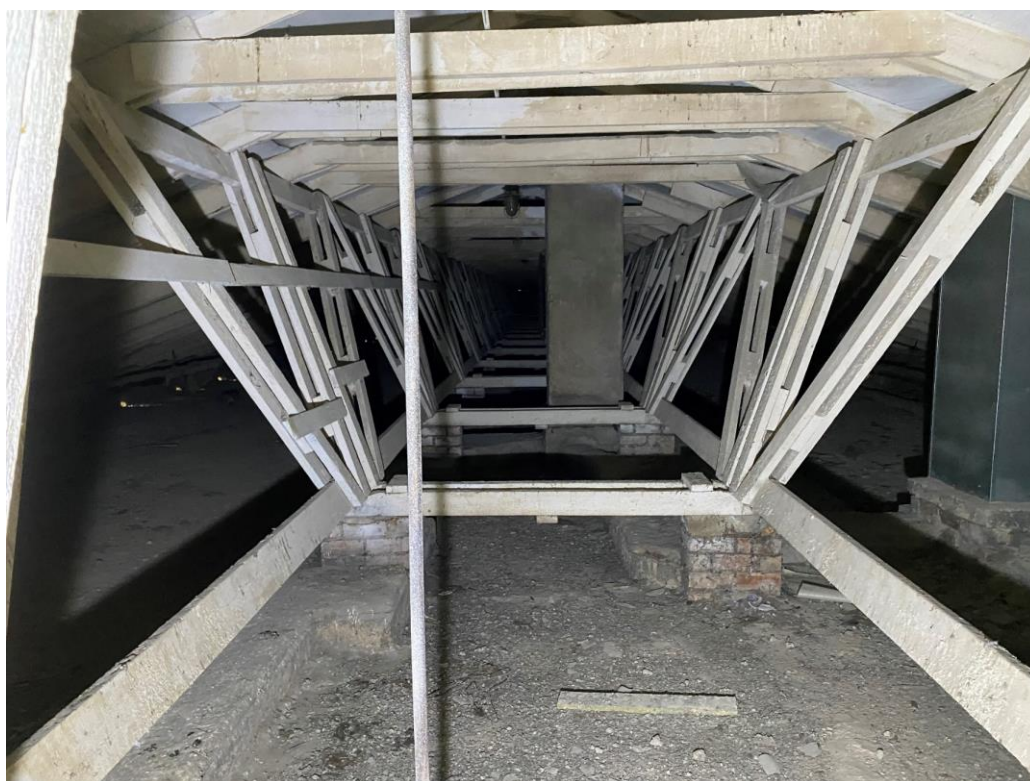
19. att. Ēkas jumta koka konstrukcijas
