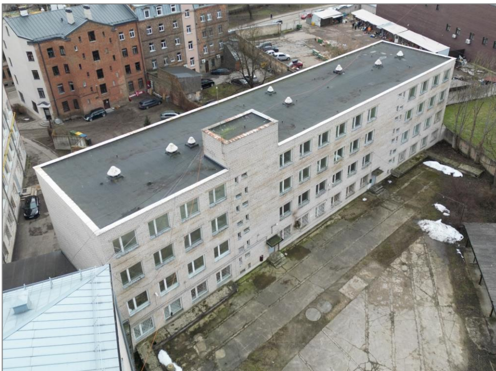
1. att. Apsekotā ēka
