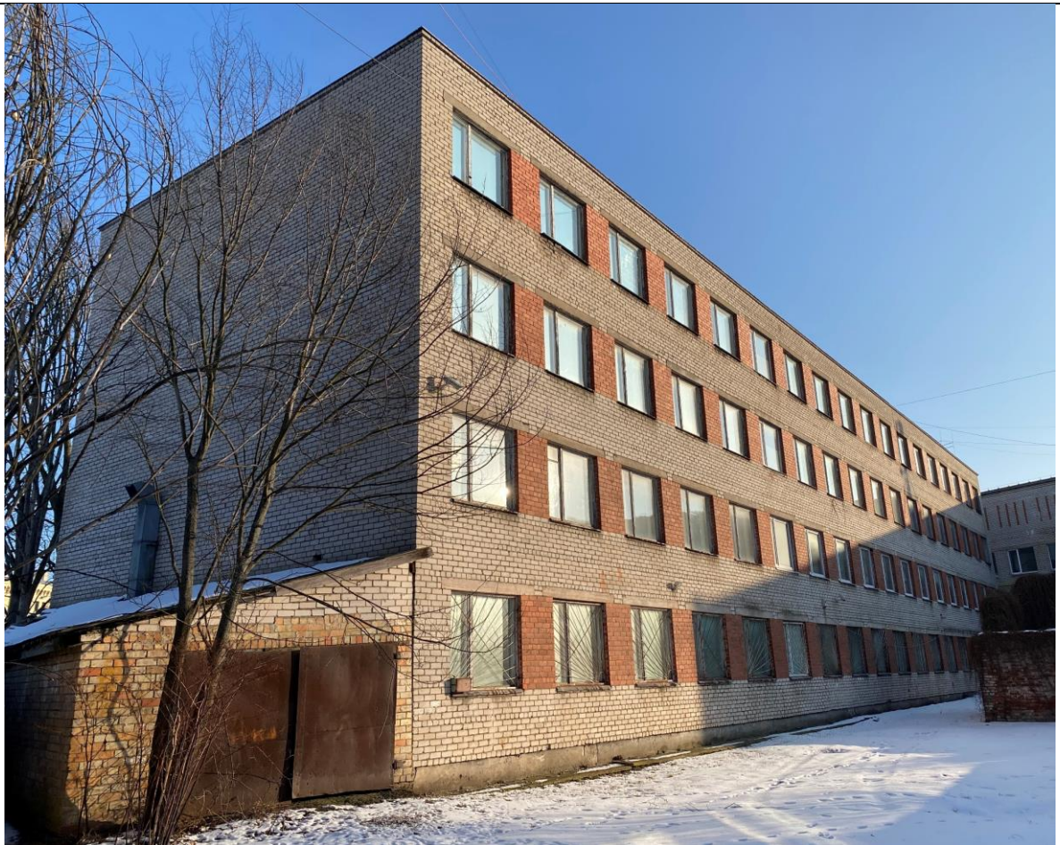
10. att. Ēkas D un R (gala) fasādes
