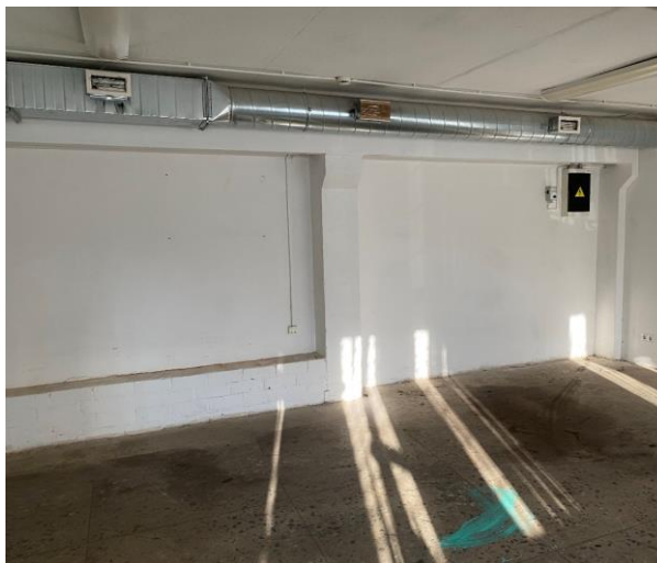
14. att. Karkasa konstrukcijas
