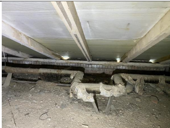
21. att. Jumta koka konstrukcijas
