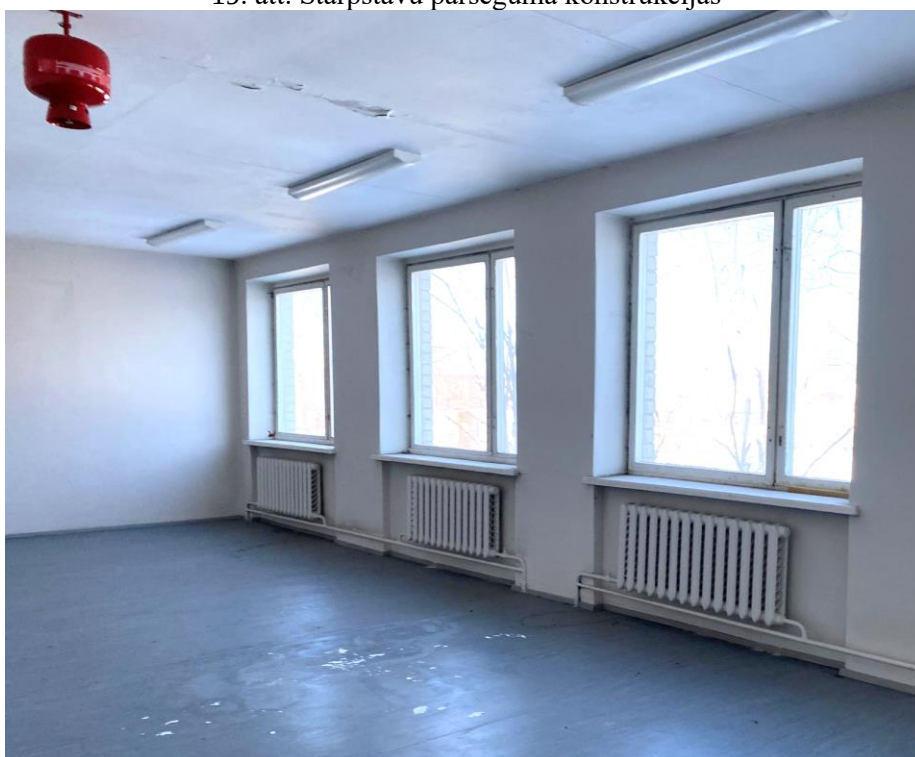
20. att. Augšstāva (4. stāva) pārsegumam lokālās zonās redzami apdares bojājumi, kas radušies mitruma iedarbības rezultātā
