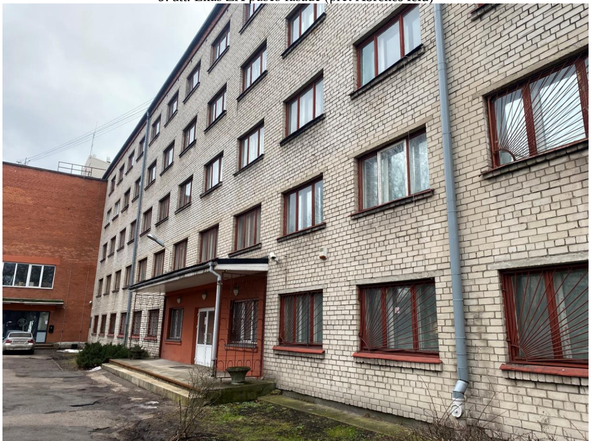
10. att. Ēkas galvenās (DA) fasādes fragments (pret Lāčplēša ielu)
