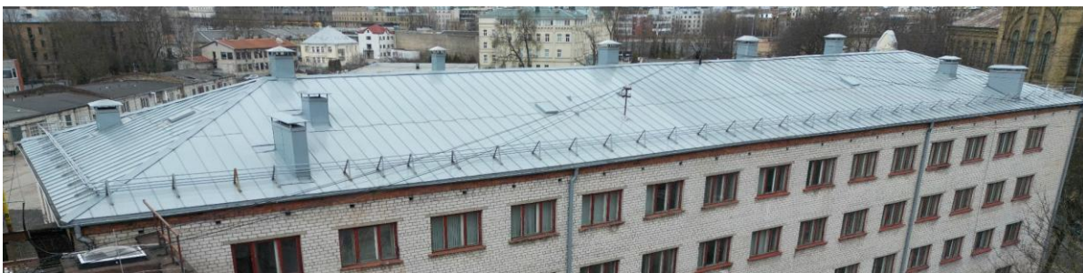
22. att. Ēkai četrslīpju jumts ar skārda lokšņu segumu
