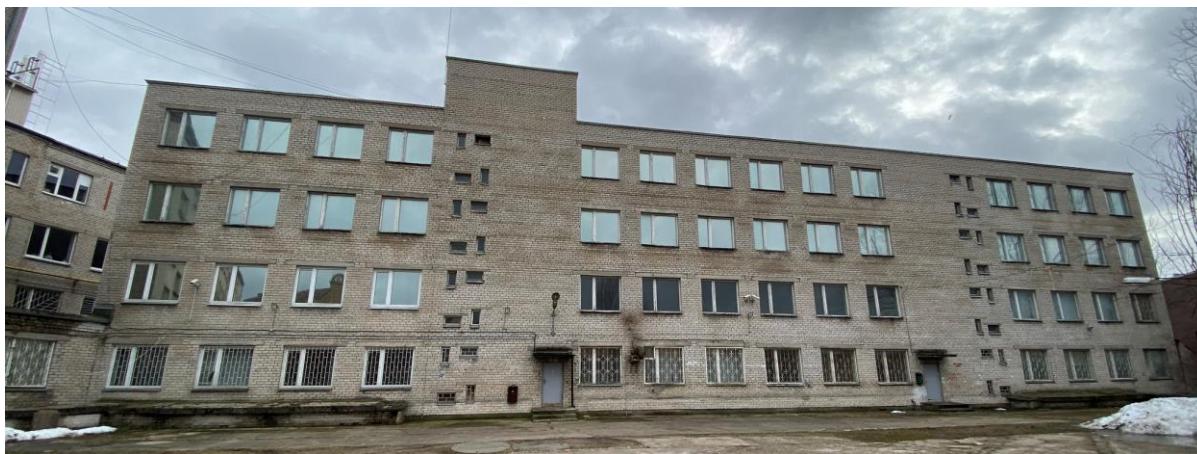
9. att. Ēkas Z puses fasāde
