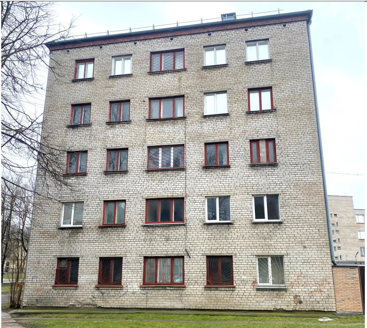
9. att. Ēkas ZA puses fasāde (pret Abrenes ielu)
