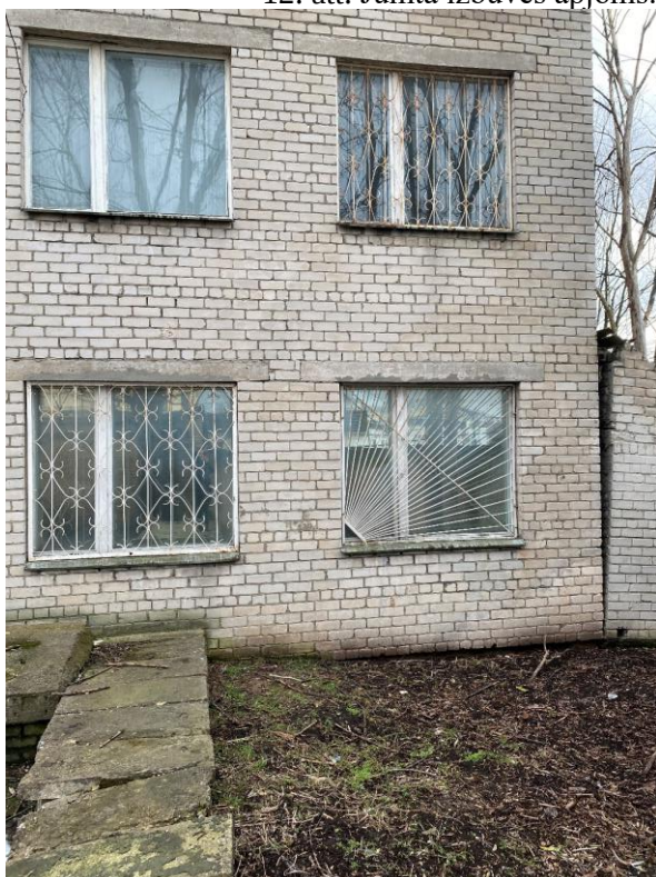
13. att. Ēkas ZR stūrī piekļaujas siltumtrase, zemes līmenis augstāks kā citviet
