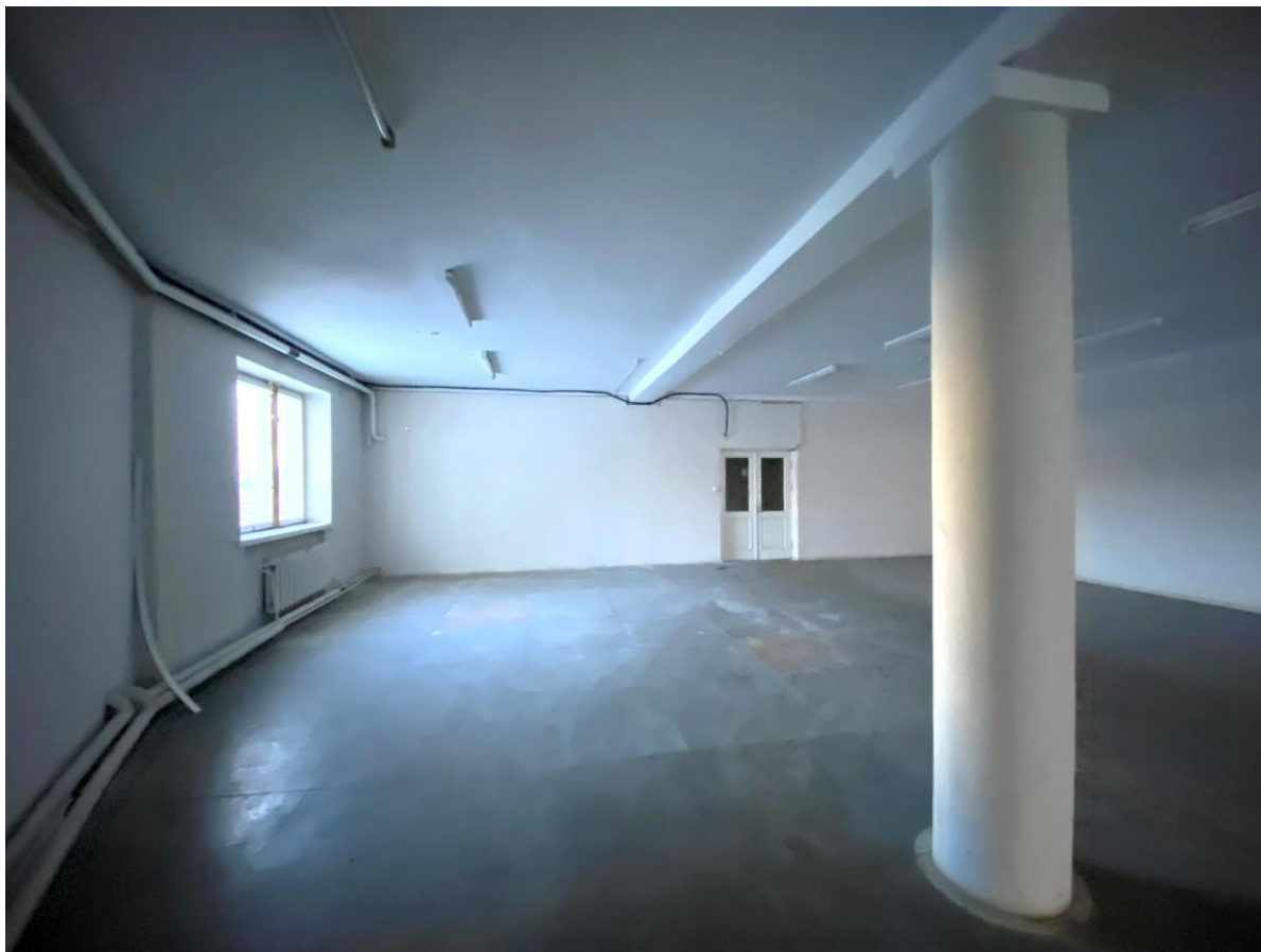
17. att. Ēkas savienošajā vestibila daļā izbūvētas karkasa konstrukcijas – kolonna un rīģelis
