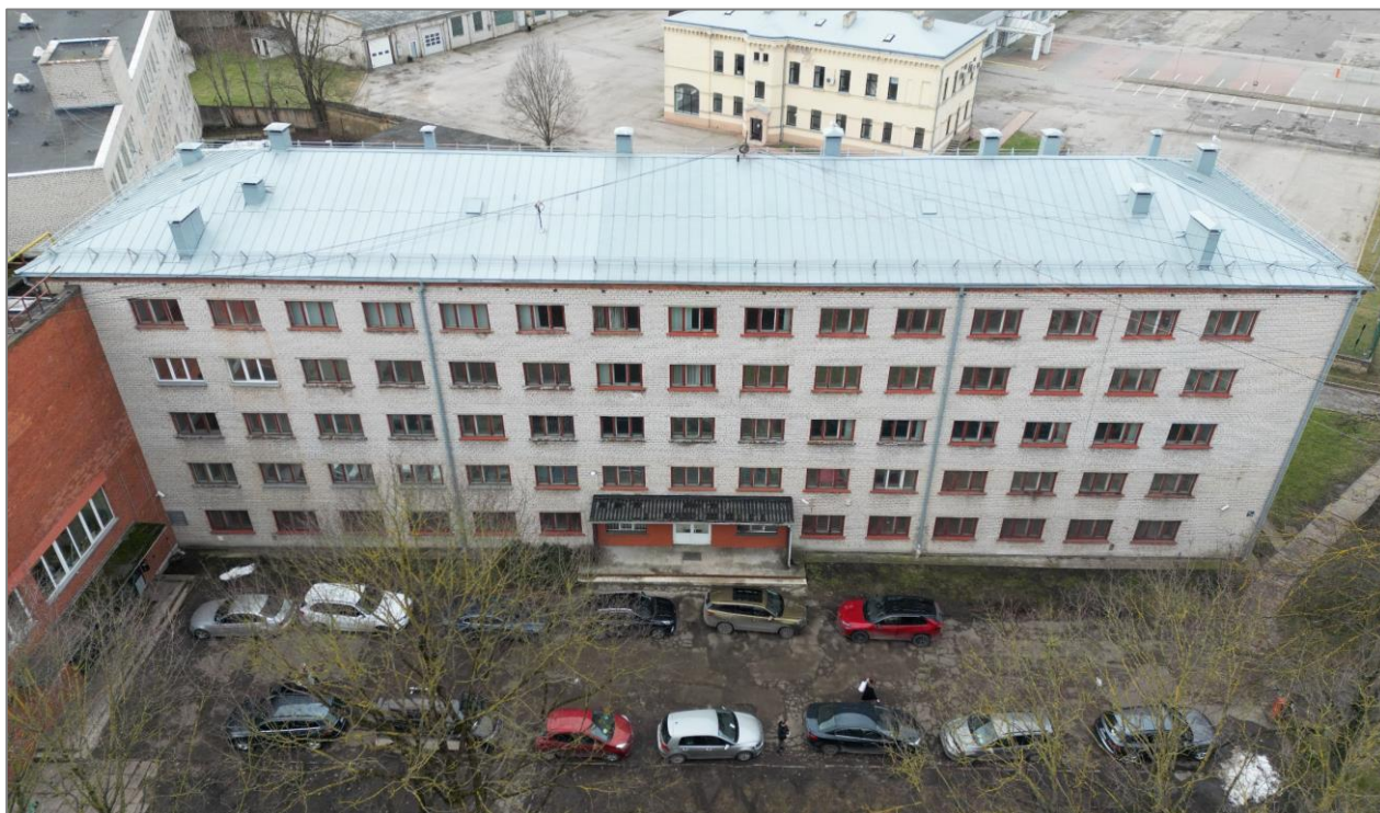
1. att. Apsekotā ēka
