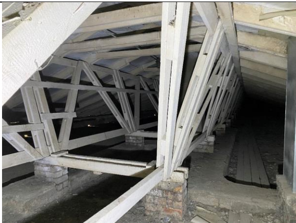
20. att. Jumta koka konstrukcijas
