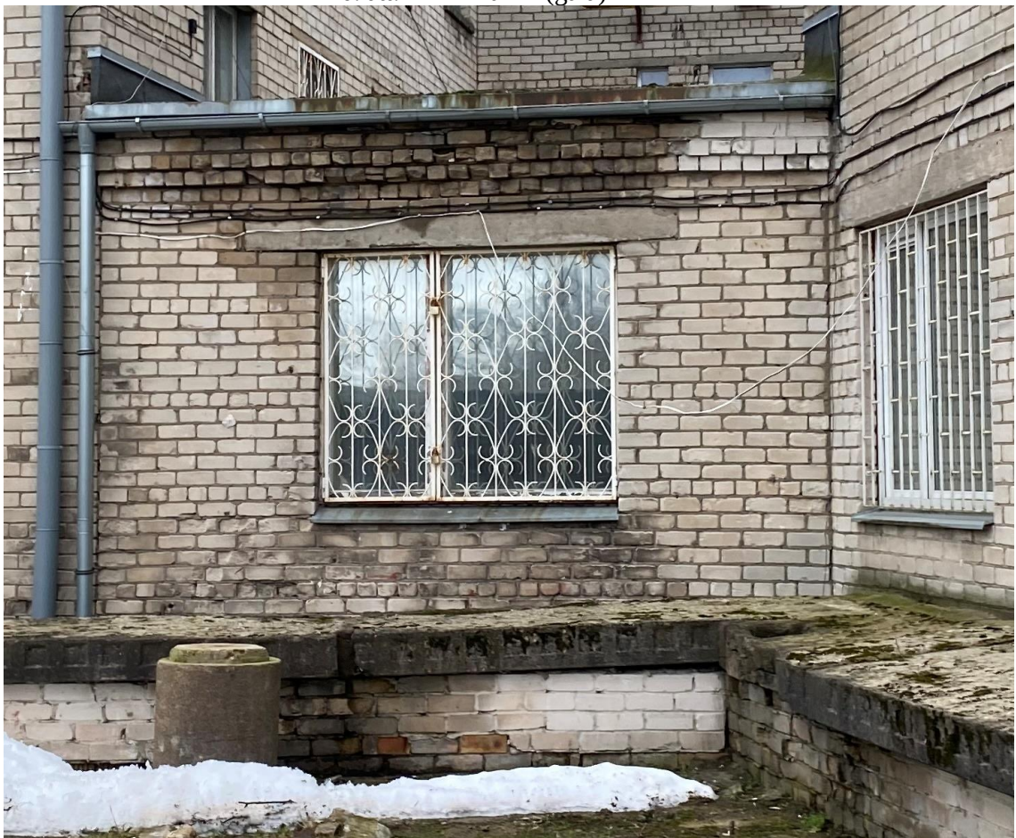
11. att. Ēkas savienošais apjoms. Uz dzegas zonas nonāk nokrišņu ūdens, veicinot mūra eroziju
