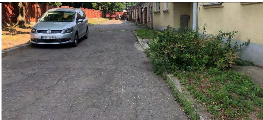
3.1.1.4. attēls. Pagalma asfaltbetona segums (pie ēkas 003)
