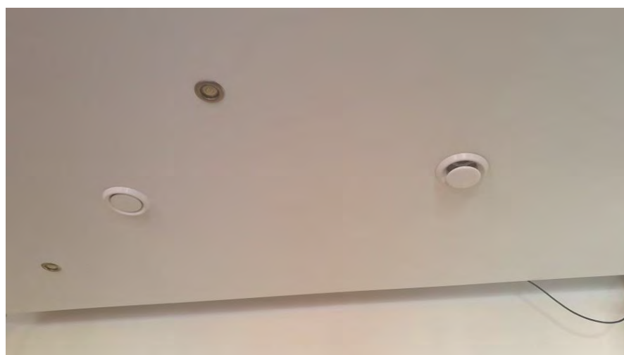
5.6.1.2.attēls. Lokāla nosūces sistēma 1.stāvā
