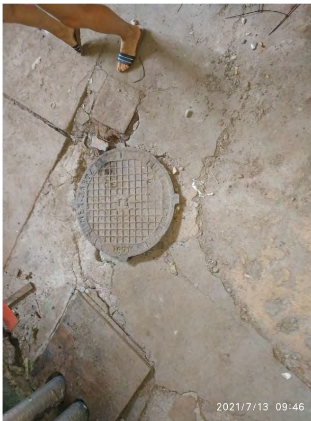
4.12.1.3. attēls. Betona klona grīda (1. stāvs, telpa Nr. 5, 001)
