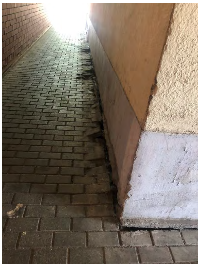
3.1.1.6. attēls. Bruģakmens segums (starp ēku 003 un 010)
