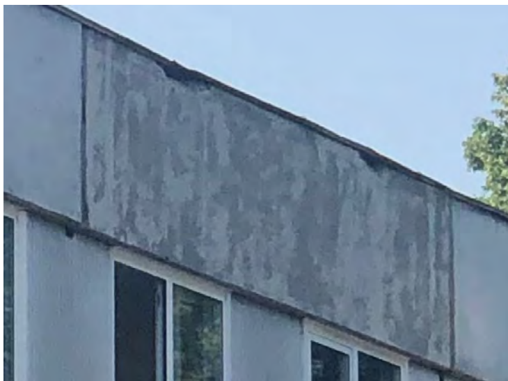
4.2.3.9. attēls. Bojāts panelis (ēkas Z fasāde)
