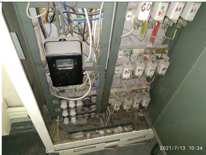
5.9.1.2. attēls. Galvenā sadalne, ar vecā tipa drošinātājiem
