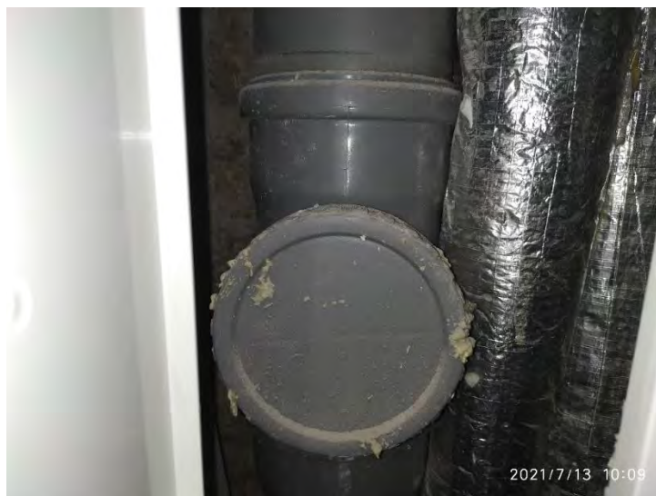
5.1.2.1. attēls. Plastmasas kanalizācijas stāvvads, aprīkots ar revīziju
