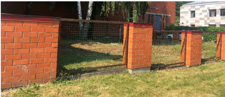
3.4.1.2. attēls. Ķieģeļu mūra stabu žogs ar dzelzsbetona pasētu un ar metāla žoga aizpildījumu
