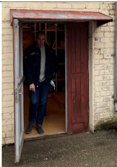
4.13.2.3. attēls. Koka ārdurvis – pildīņu tipa
