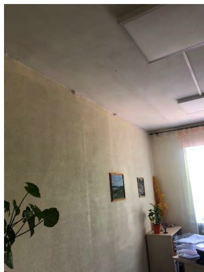
4.18.1.5. attēls. Krāsots apmetums – 3. stāvs, telpa Nr. 4 (015)
