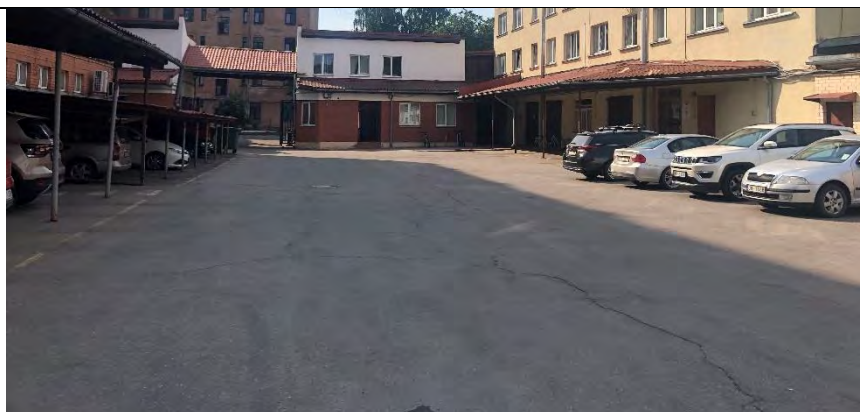
3.1.1.3. attēls. Pagalma asfaltbetona segums (iekšpagalms)
