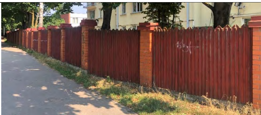
3.4.1.1. attēls. Ķieģeļu mūra stabu žogs ar dzelzsbetona pasēti un ar koka žoga aizpildījumu (foto no iepriekšējās apsekošanas – 13.07.2021.)
