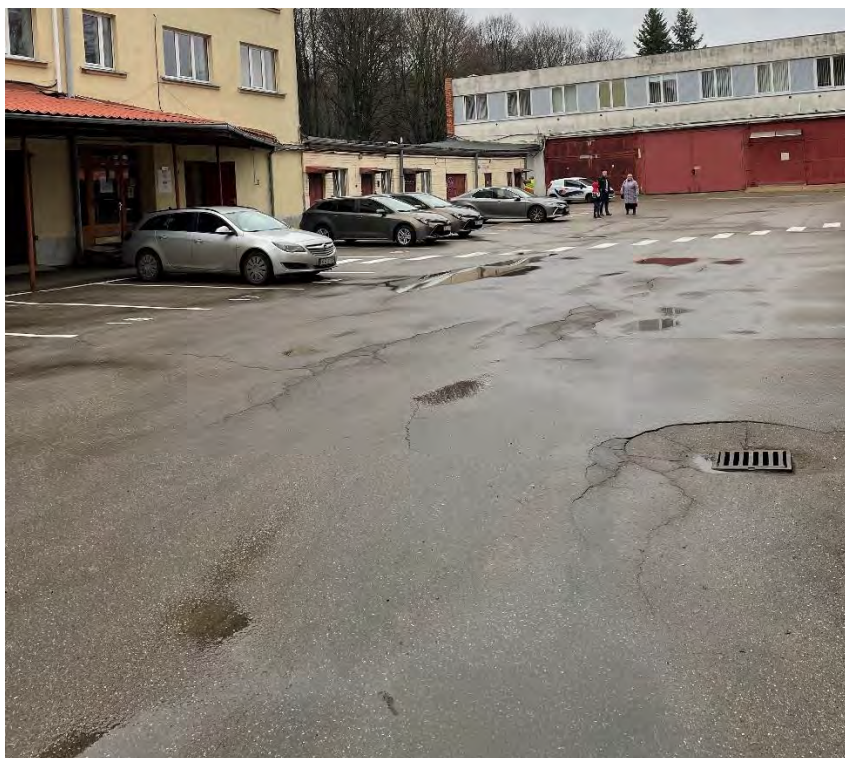
3.1.1.2. attēls. Pagalma asfaltbetona segums (iekšpagalms)
