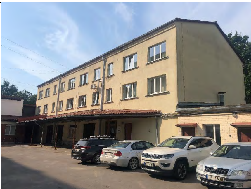
4.19.1.1. attēls. Ēkas pagalma (A un Z) fasāde
