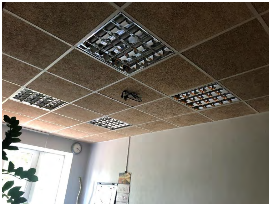
4.18.1.9. attēls. Krāsots apmetums, piekārtie griesti – 3. stāvs, telpa Nr. 3 (012)
