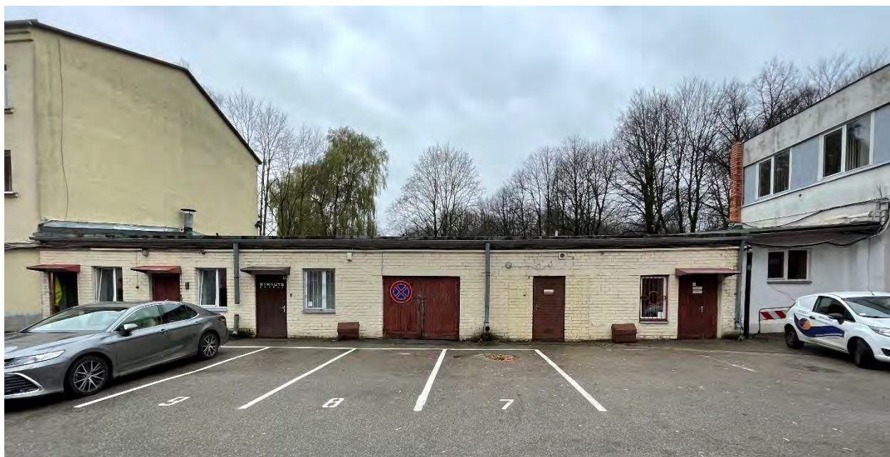
1. attēls. Garāža-darbnīca Klijānu ielā 7, Rīgā
