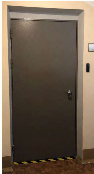
4.13.2.7. attēls. Metāla iekšdurvis (skats no kāpņu telpas)
