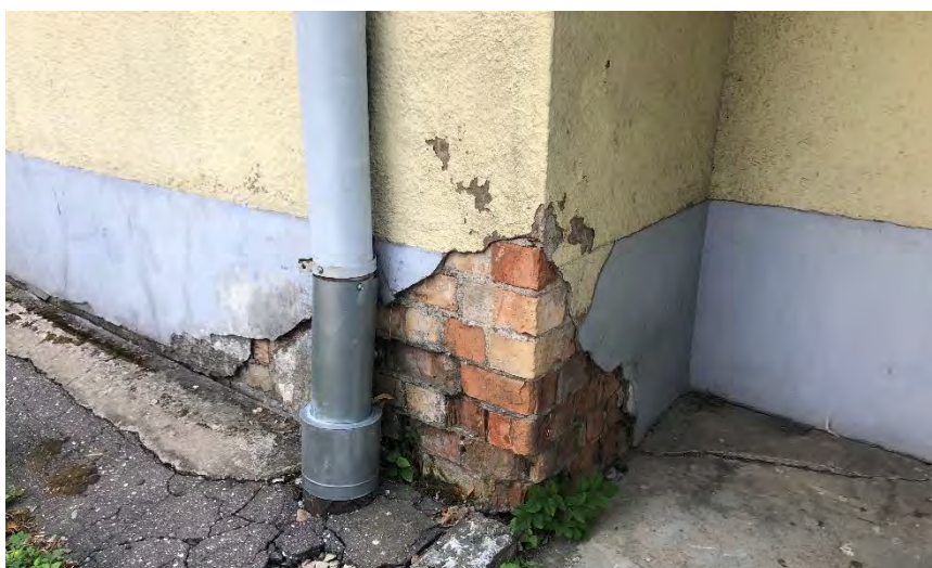
4.19.1.3. attēls. Nodrupusi apdare virspamatu zonā (ēkas R fasāde)
