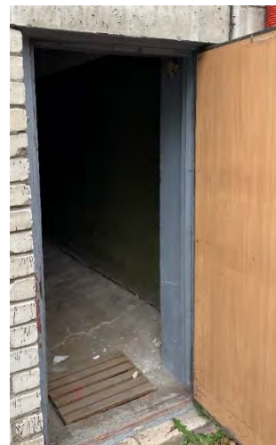
4.13.2.7. attēls. Koka ārdurvis – paneļu tipa
