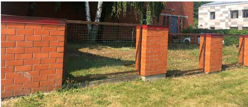
3.4.1.2. attēls. Ķieģeļu mūra stabu žogs ar dzelzsbetona pasēti un ar metāla žoga aizpildījumu (foto no iepriekšējās apsekošanas – 13.07.2021.)
