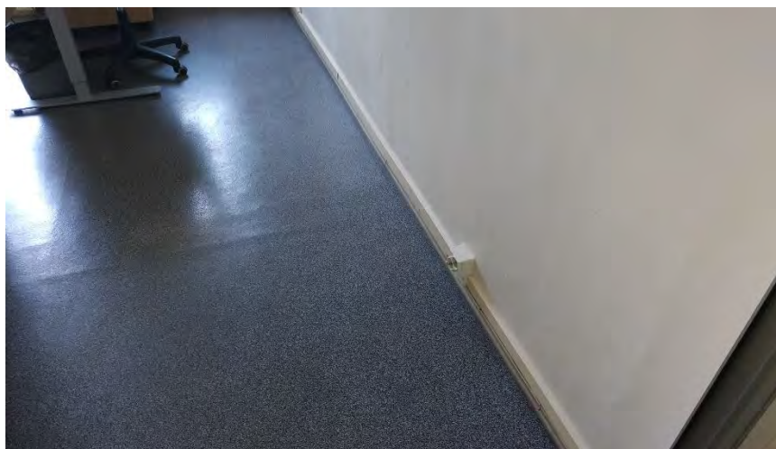
4.12.1.9. attēls. Linoleja grīdas segums (3. stāvs, telpa Nr. 4, 015)
