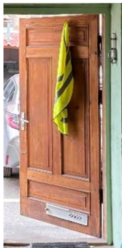
4.13.2.5. attēls. Koka ārdurvis – pildīņu tipa (skats no iekšas)
