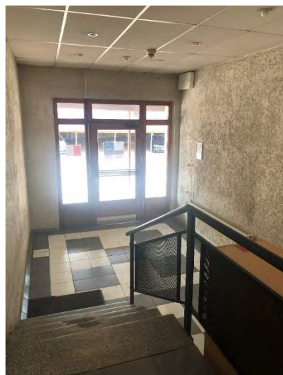
4.18.1.4. attēls. Krāsots dekoratīvais apmetums, piekārtie griesti – 1. stāvs, telpa Nr. 2 (901)
