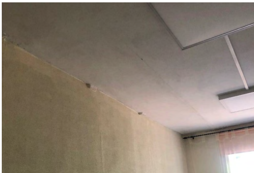
4.6.2.1. attēls. Bēniņu pārsegums (3. stāvs, telpa Nr. 5, 014)
