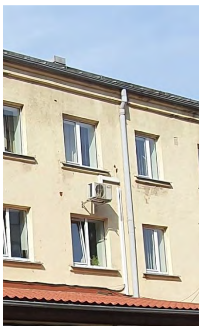
5.6.1.6.attēls. Dzesēšanas ārējais bloks uz fasādes
