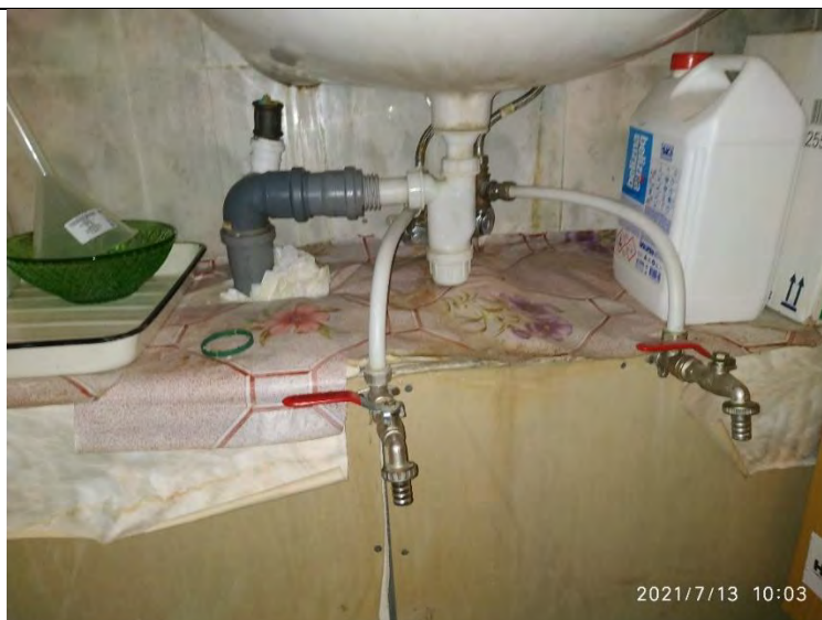
5.1.1.3. attēls. Paštaisīti krāni telpu apkopes vajadzībām
