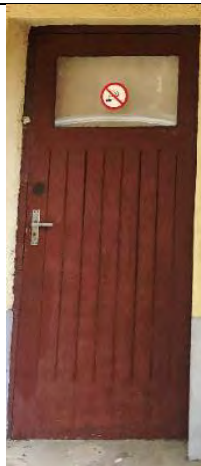
4.13.2.1. attēls. Koka paneļu tipa ārdurvis (ēkas R fasāde)
