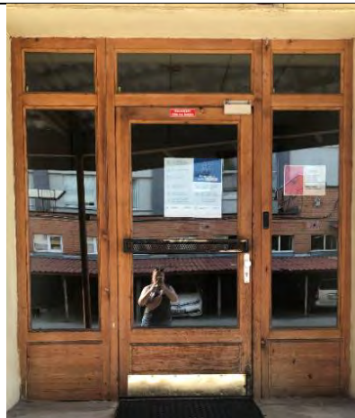
4.13.2.3. attēls. Stiklotas pildīņu tipa koka ārdurvis (ēkas A fasāde)
