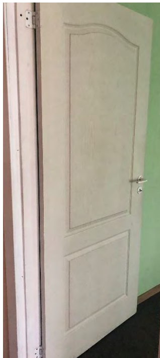
4.13.2.4. attēls. Koka iekšdurvis – pildīņu tipa
