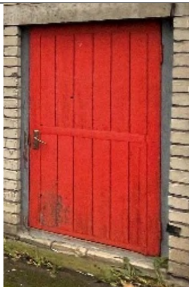
4.13.2.4. attēls. Koka ārdurvis – paneļu tipa
