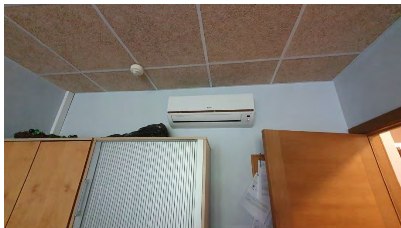
5.6.1.5.attēls. Dzesēšanas iekšējais bloks
