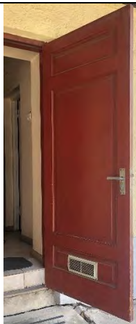
4.13.2.2. attēls. Koka pildīņu tipa ārdurvis (ēkas A fasāde)
