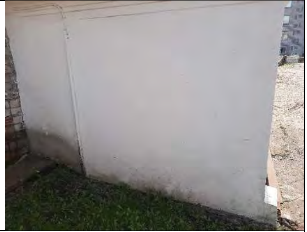
Iejas mezglā sāni ar redzamām ūdens ietekmes pēdām. Vizuāli saplaisājis, bet noturīgs apmetums.
