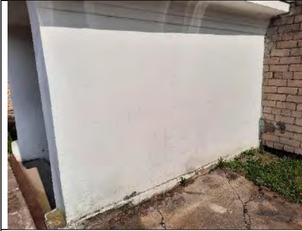
Iejas mezglā sāni ar redzamām ūdens ietekmes pēdām. Vizuāli saplaisājis, bet noturīgs apmetums.
