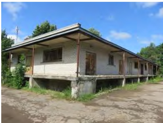
1.2.6-1 Ēkai nav nodrošināta aizsardzība pret nokrišanu no augstuma.
