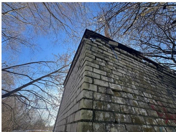
Skats uz hlorētāvu
