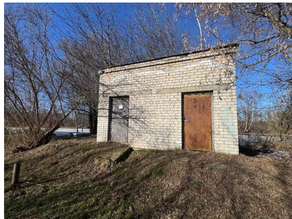
Skats uz Objektu
