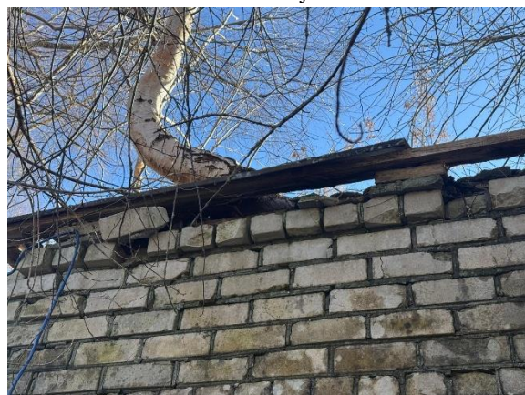
Skats uz hlorētāvu
