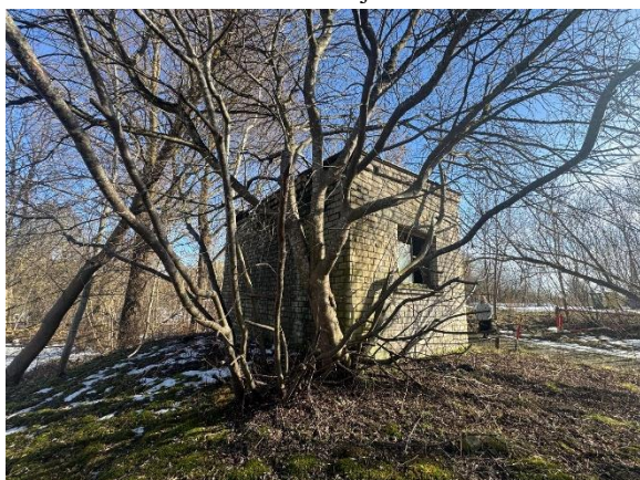
Skats uz hlorētāvu
