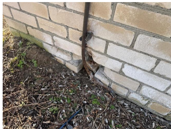
Skats uz hlorētāvu
