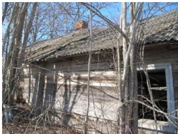
Bijušās dzīvojamās mājas fasādes daļa, jumta segums- azbestcements loksnes (šiferis)
