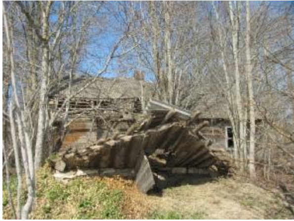
Laukakmeņu mūra pagrabs zem zemes, jumta daļa virs pagraba sabrukusi
