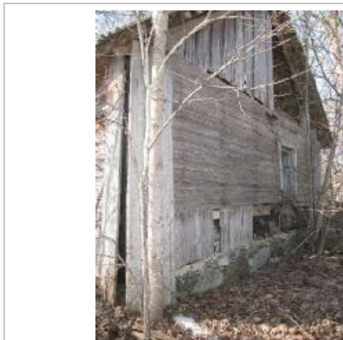
Bijušās dzīvojamās mājas fasādes daļa, pamati – laukakmeņu mūris, koka konstrukcijas sapuvušas
