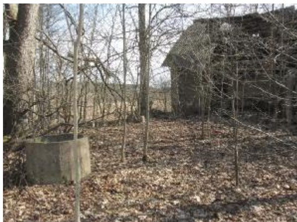
Bijušās dzīvojamās mājas, kad. apzīmējums 7094 002 0197 001, pagalmā atrodas dz/betona grodu aka (ūdens akā nav)
