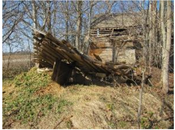
Laukakmeņu mūra pagrabs zem zemes, jumta daļa virs pagraba sabrukusi
