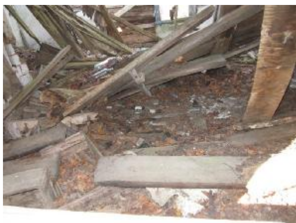
Iekštelpas ar iebrukušiem griestu un jumta elementiem
