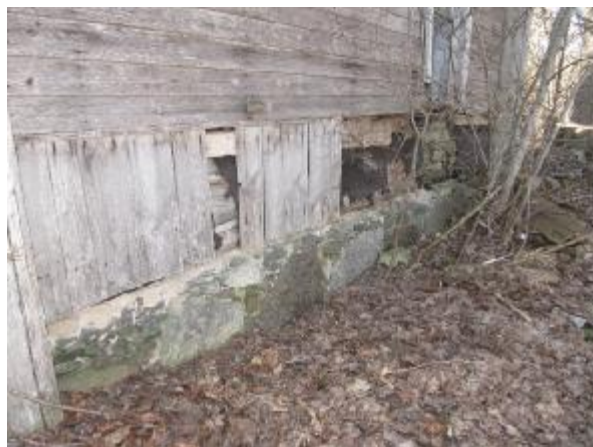
Bijušās dzīvojamās mājas fasādes daļa, pamati – laukakmeņu mūris, koka konstrukcijas sapuvušas
