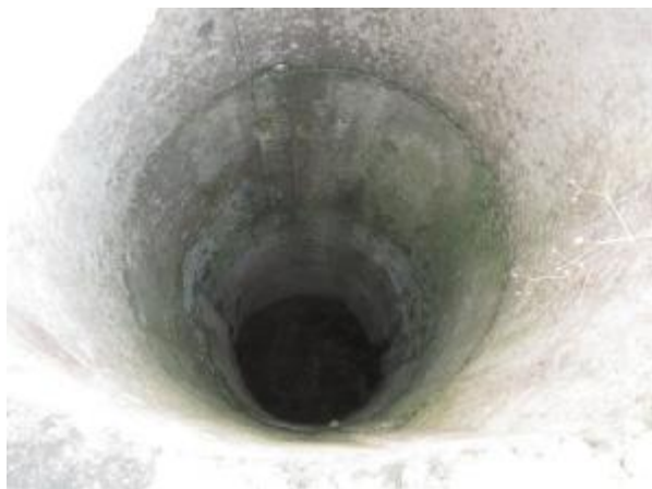
Pagalmā izbūvēta dz/betona grodu aka (ūdens akā nav)
