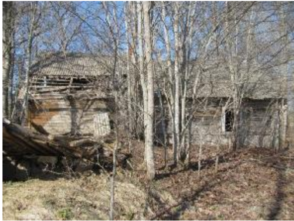
Laukakmeņu mūra pagrabs zem zemes, jumta daļa virs pagraba sabrukusi
