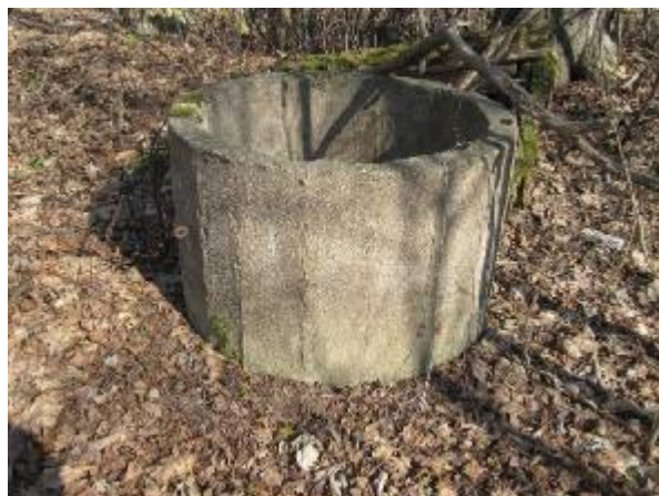
Bijušās dzīvojamās mājas, kad. apzīmējums 7094 002 0197 001, pagalmā atrodas dz/betona grodu aka (ūdens akā nav)
