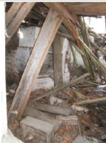
Iekštelpas ar iebrukušiem griestu un jumta elementiem
