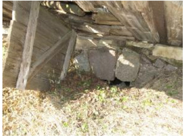
Laukakmeņu mūra pagrabs zem zemes, jumta daļa virs pagraba sabrukusi
