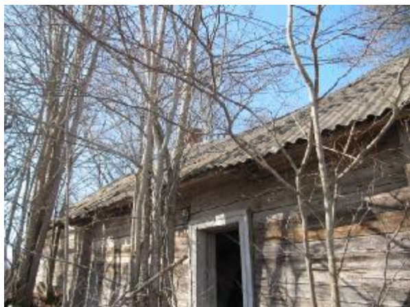
Bijušās dzīvojamās mājas fasādes daļa, jumta segums- azbestcements loksnes (šiferis)
