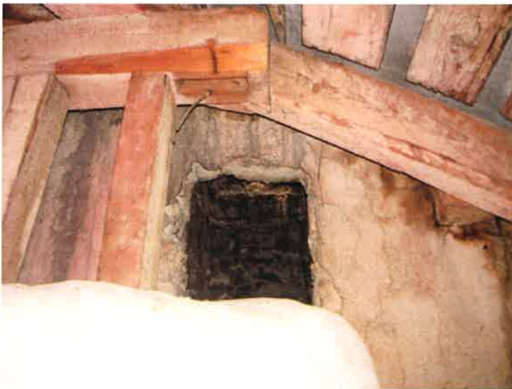
Bēniņos sakārtot dūmvadu tīrīšanas lūkas
