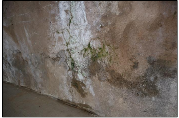
Mitruma radīti traipi kāpņu apakšējā daļā un pārmitra, izsāļojumu, bioloģiskā apauguma bojāta sienas virsma 1. stāvā, kadru Nr. IMG_2959, IMG_2949.
