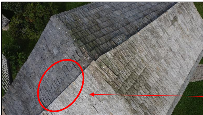
Jumta seguma bojājumi, kadru Nr. IMG_2934, DJI_0954, DJI_0952.
