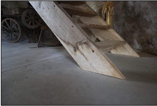
Mitruma radīti traipi kāpņu apakšējā daļā un pārmitra, izsāļojumu, bioloģiskā apauguma bojāta sienas virsma 1. stāvā, kadru Nr. IMG_2959, IMG_2949.
