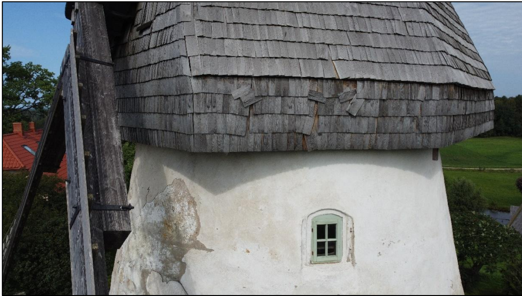
Mitruma radīti traipi kāpņu apakšējā daļā un pārmitra, izsāļojumu, bioloģiskā apauguma bojāta sienas virsma 1. stāvā, kadru Nr. IMG_2959, IMG_2949.
