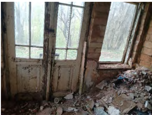
19.attēls. Veranda (1.stāva telpa Nr.6)
