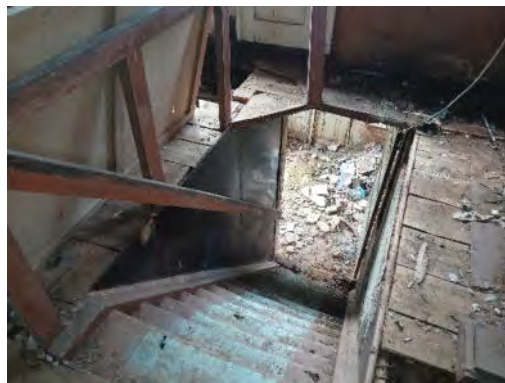
20.attēls. Kāpņu telpa (1.stāva telpa Nr.8)
