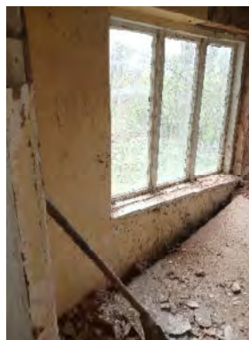
18.attēls. Veranda (1.stāva telpa Nr.6)
