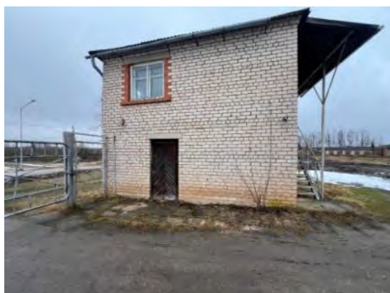
2.attēls. Caurlaides ēka (68170030239001)
