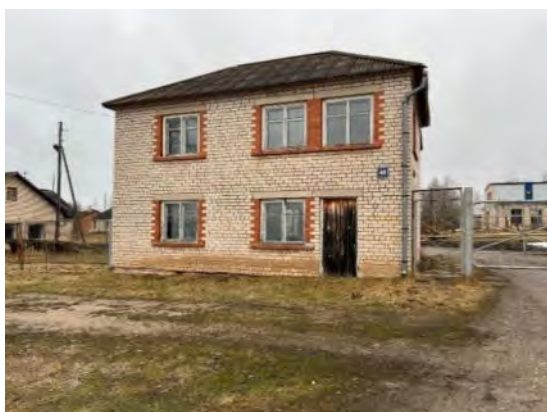
1.attēls. Caurlaides ēka (68170030239001)
