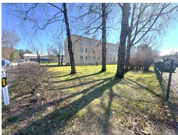
Skats uz Objektu
